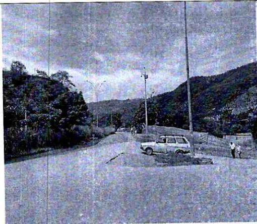
FOTO 1 ISLETA DE INSTALACION
