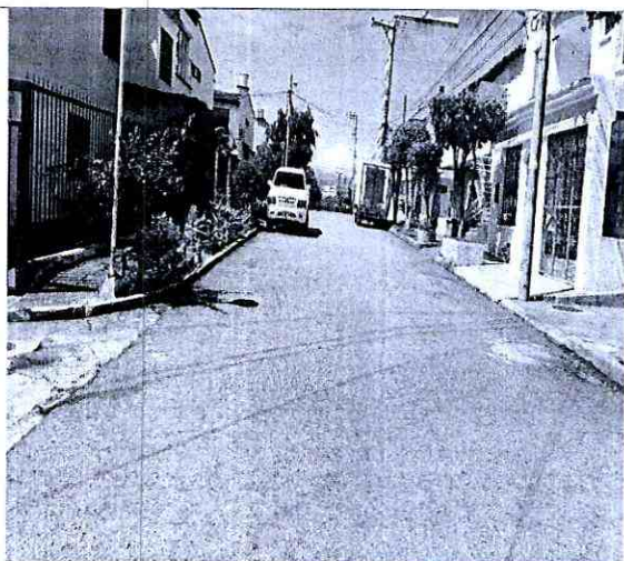
Imagen 1: Calle 107 entre carrera s 24 a 25 Barrio: Provenza
