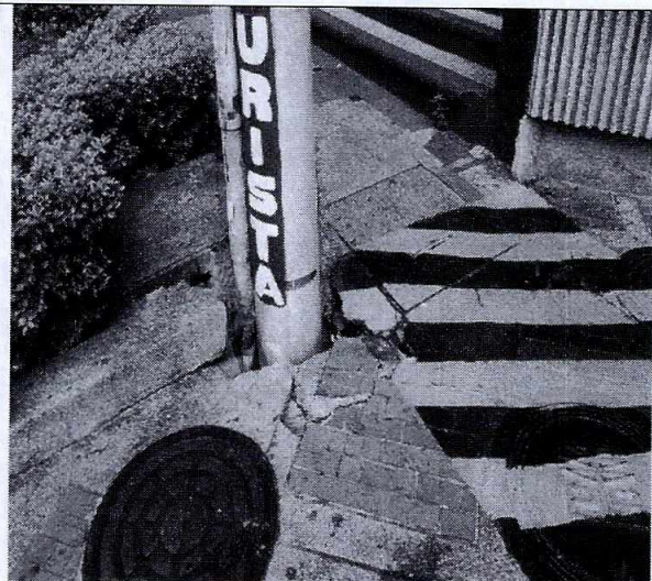
Imagen 4: calle 52 # 31-126. Barrio: Cabecera
