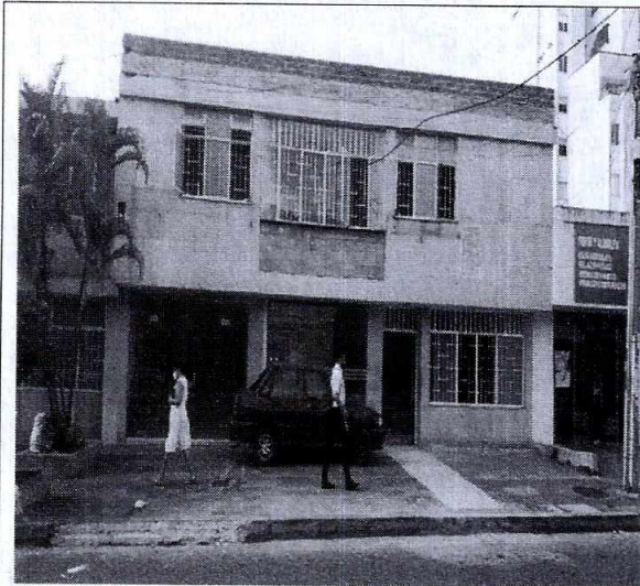
Imagen 1: calle 52 # 31-126. Barrio: Cabecera
