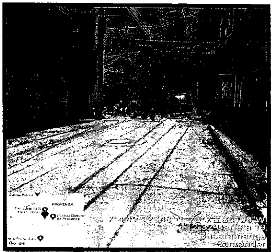
Imagen 11: Carrera 21ª No 115. Calzada en concreto
