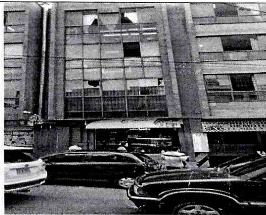
Imagen 2: Calle 33 N° 16-70 Barrio: Centro
