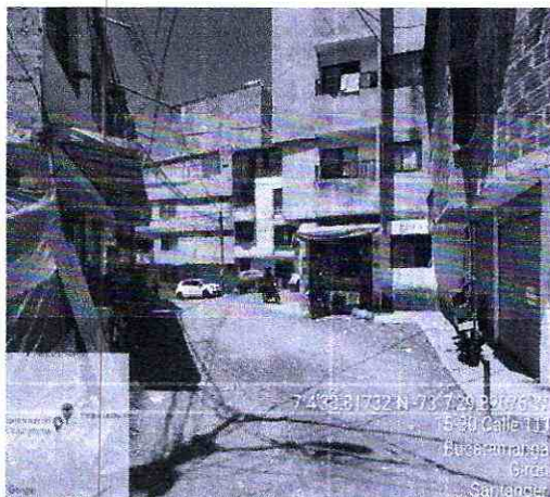
Imagen 3: Calzada vehicular sin pavimentar, de la carrera 15 Bis. Barrio Punta Paraiso
