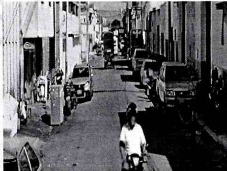
Imagen 4: panorámica de la vía en sentido Sur-Norte, en pavimento flexible en condiciones regulares.
