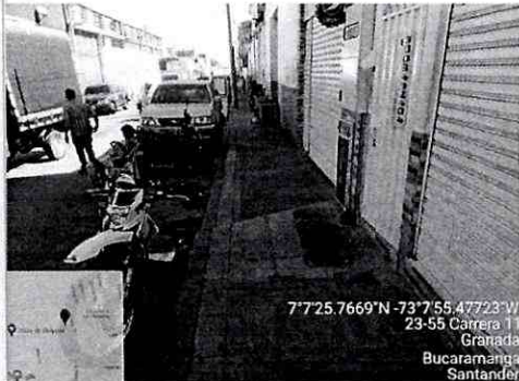
Imagen 3: Panorámica de la franja de circulación costado oriente se observa en estado regular
