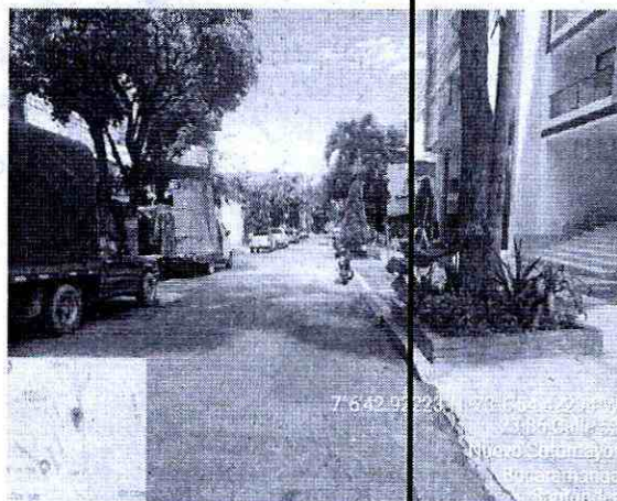
Imagen 4: Panorámica de la vía Costado Oriente- Occidente en la calle 53 No 23-67 Barrio Bolarqui
