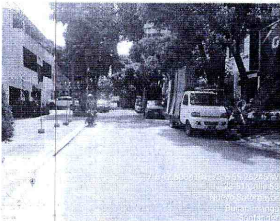
Imagen 3: Panorámica de la vía Sentido occidente – oriente, se observa en estado regular, debido a intervención del EMPAS que hizo al predio nuevo y que no ha sido recuperado
