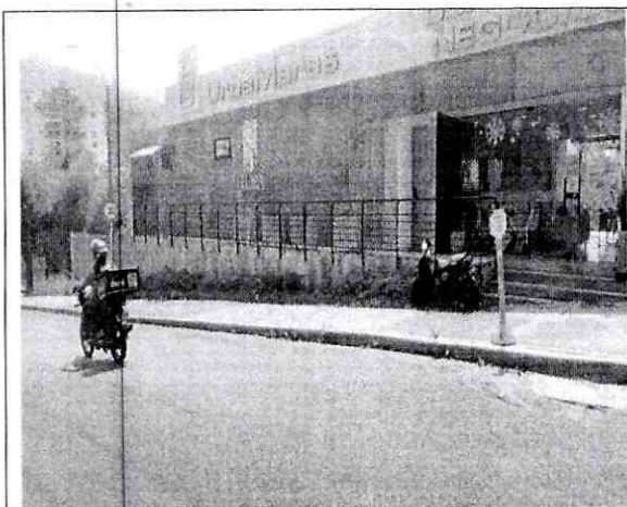
Imagen 1: Carrera 36 Vía antigua Florida blanca
