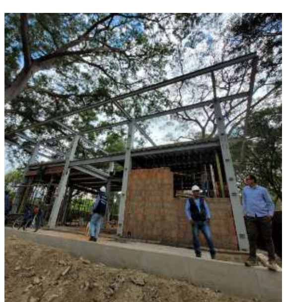
Estructura metálica y mampostería de los módulos
