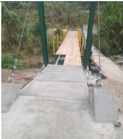
Accesos al puente terminados se construyeron placas en concreto reforzado, se observa instalada baranda.
