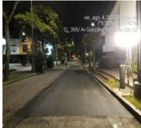
BARRIO BOLARQUÍ DESPUES
