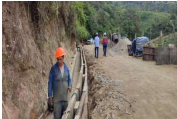
Construcción alcantarilla vereda aburrido alto
