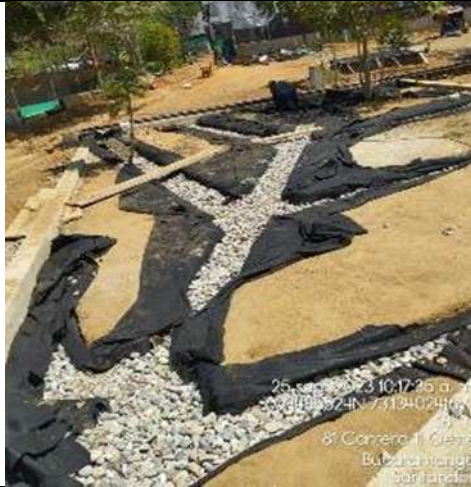
Construcción filtros zonas juegos infantiles
