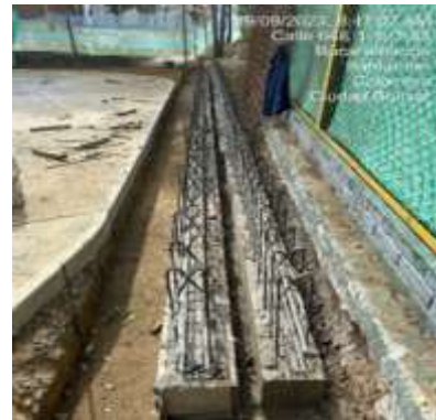
CONSTRUCCION BANCA Y GIMNASIO
