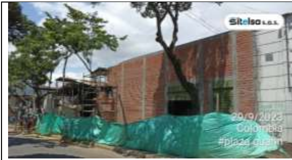
ACTUAL: Fachada perimetral sobre la carrera 33
