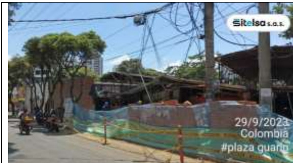
ACTUAL: Cimentación y construcción de fachada carrera 33a
