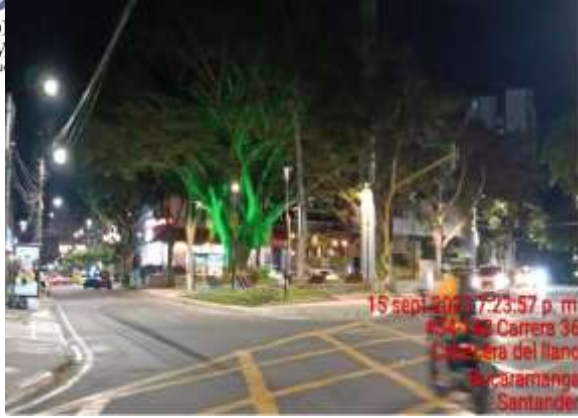
Funcionamiento Luminarias instaladas
