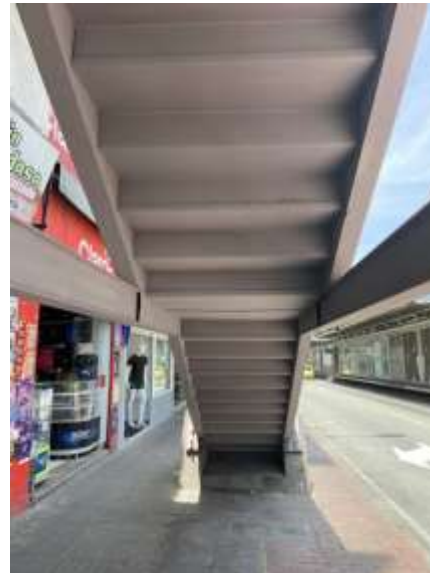
Mantenimiento cara inferior lamian metálica alfajor piso escaleras
