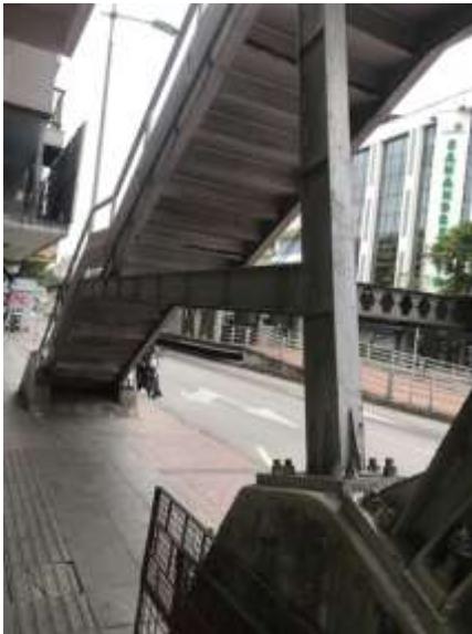
Mantenimiento cara inferior lamian metálica alfajor piso escaleras
