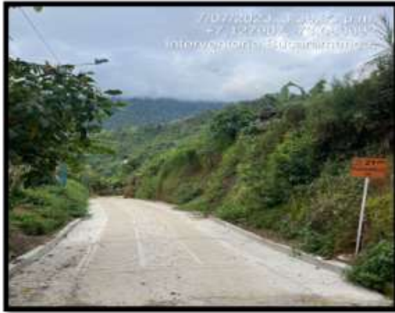
Construcción placa huella V. San José C-3
