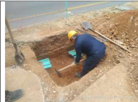
Construcción de caja de inspección
