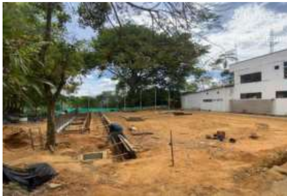
CONSTRUCCION ZONA CANCHA Y GIMNASIO
