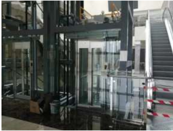
INSTALACION DE ASCENSOR PANORAMICO
