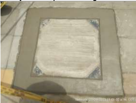
Instalación de marco y tapa en caja de inspección.
