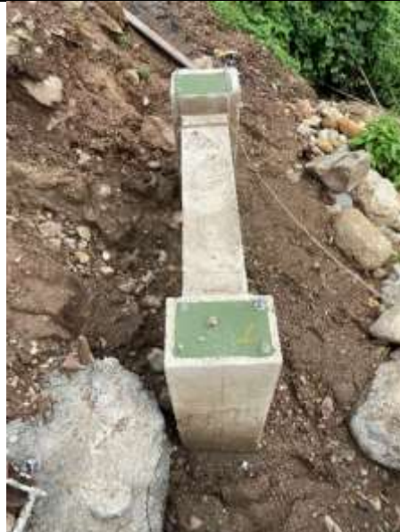
Anclaje pilastra IPE 240 a columna concreto
