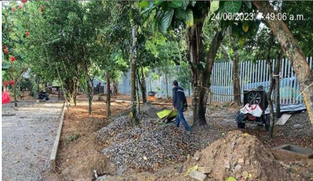
CONSTRUCCION CERRAMIENTO- SENDEROS PEATONALES
