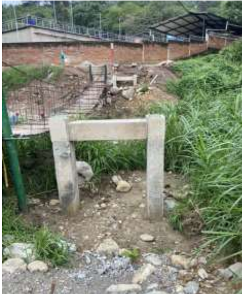
Concreto 21 Mpa mezclado en sitio para
