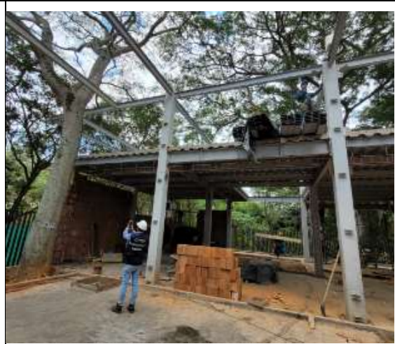
Estructura metálica y mampostería de los módulos
