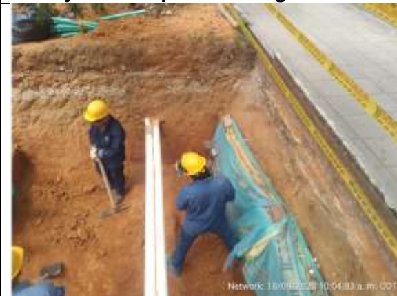
Excavación subestación
