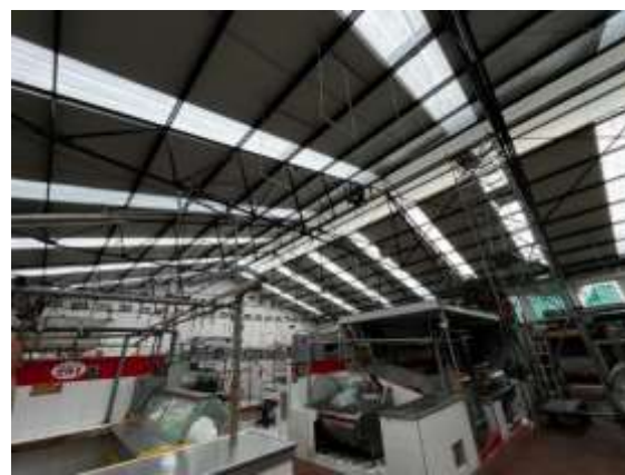
ACTUAL: Cubierta zona de carnes fase 1
