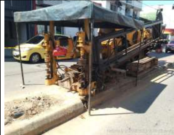
Trabajos con topo misil dirigido
