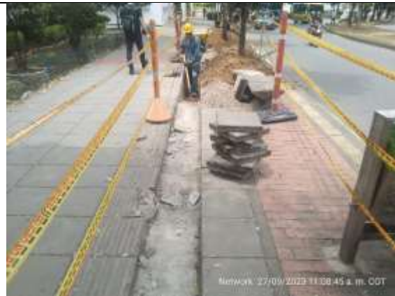
Demolición de loseta para instalación de ducteria
