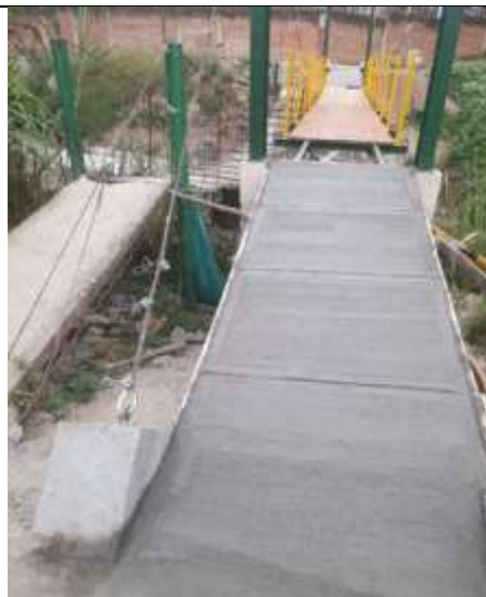
Accesos al puente terminados se construyeron placas en concreto reforzado, se observa instalada baranda.
