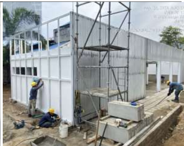
ACTUAL: Vista estructura metálica, fachada exterior
