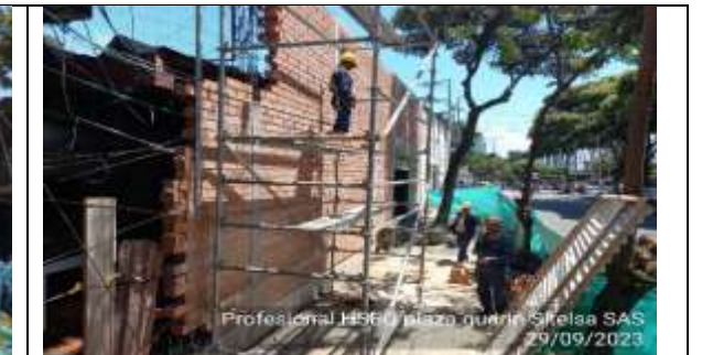
ACTUAL: Trabajos de fachada sobre la carrera 33.
