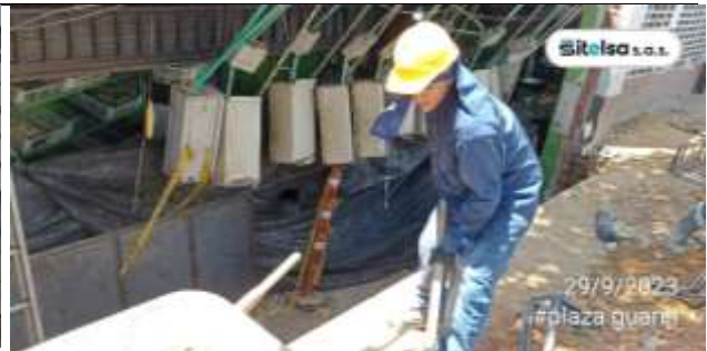
ACTUAL: Construcción de muros sobre la carrera 33a
