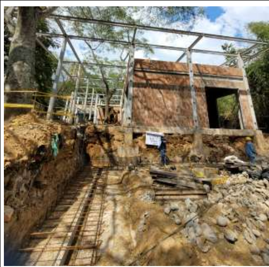
Acero para la construcción de la rampa
