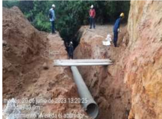
Construcción de canaletas vereda aburrído alto
