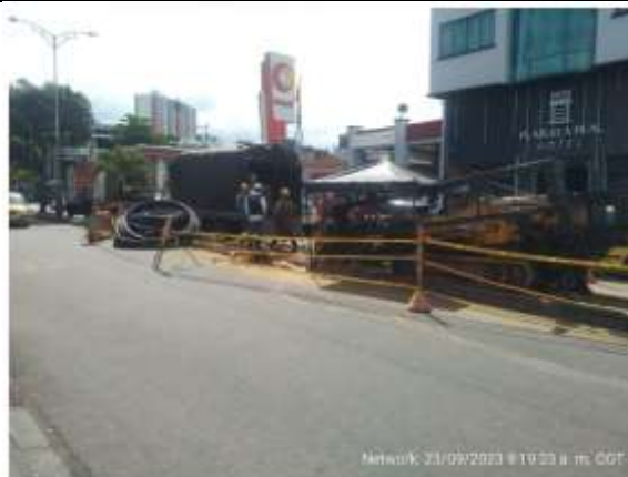
Trabajos con topo misil dirigido
