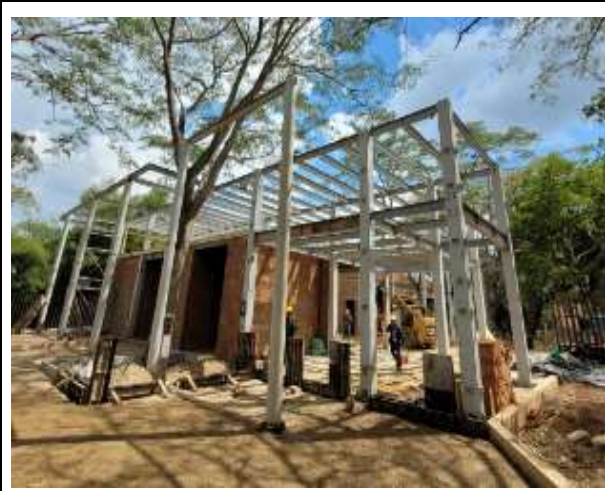
Estructura metálica y mampostería de los módulos
