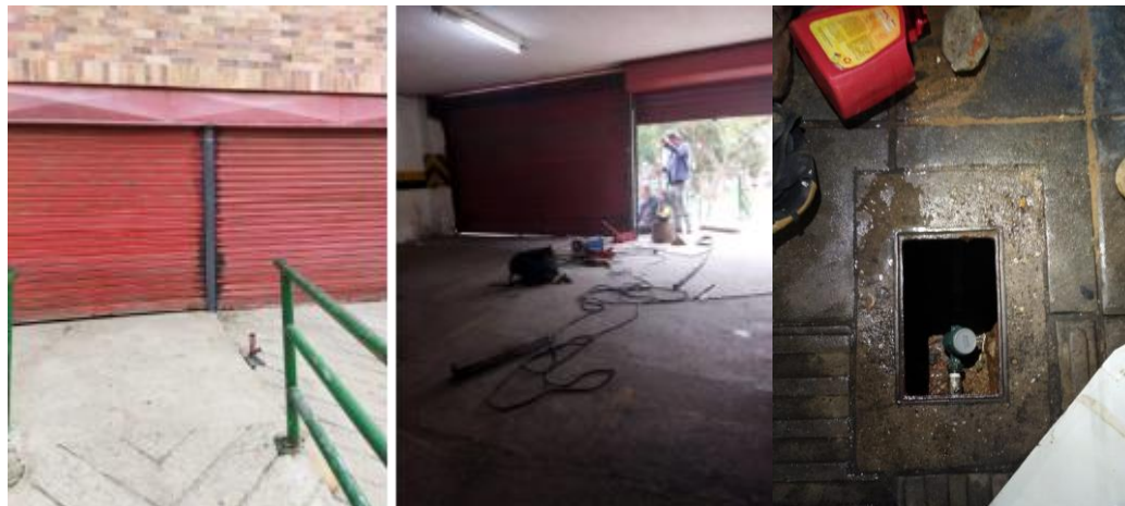
KENNEDY: Actividades de soldadura y cambio de llave del registro de agua.
