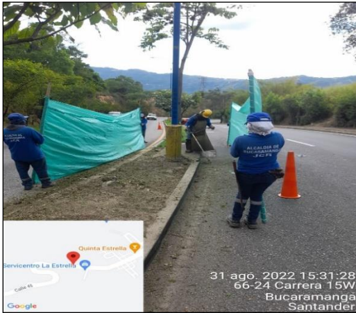
Intervención sobre la Calle 45 Vía Chimita
