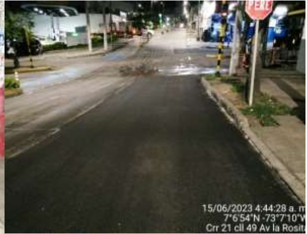
BARRIO LA CONCORDIA DESPUES
