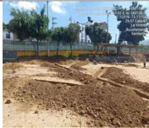
CONSTRUCCION CANCHA DE FUTBOL, GRADERIA CON CUBIERTA, CANCHA MULTIPLE Y SENDEROS PEATONALES
