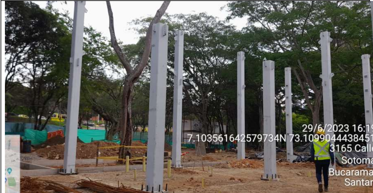
Izado de estructura metalica, modulo A y B
