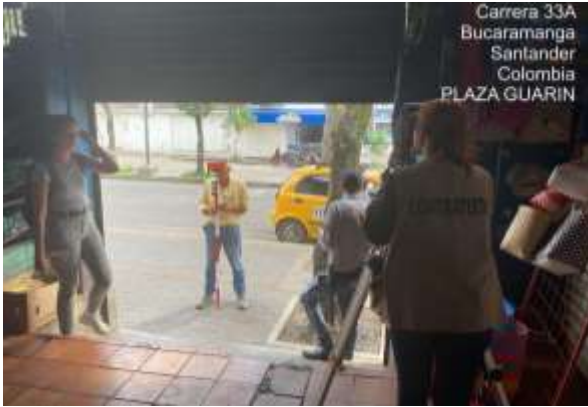
ACTUAL: Localización y replanteo de Columnas existentes.
