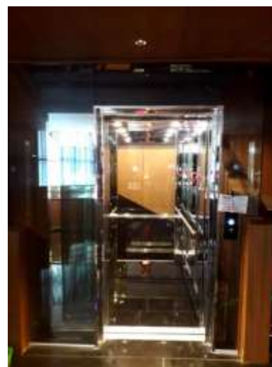
INSTALACION DE ASCENSOR
