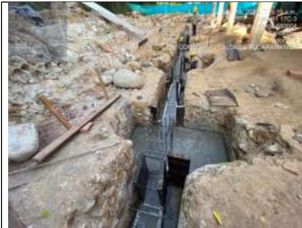
ACTUAL: Zapata en concreto 3000 PSI mezclada con arena y grava en el sitio.
