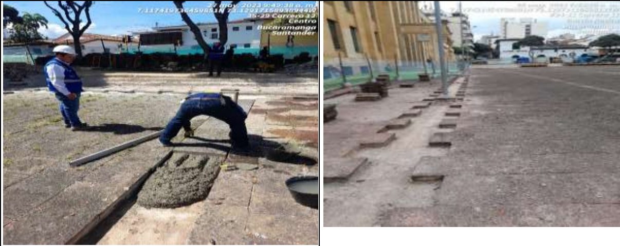
Corte y demolición de pavimento asfáltico con compresor diésel y martillo, incluye cargue y retiro de material.
