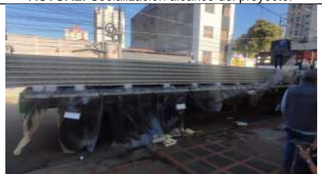
ACTUAL: Almacenamiento de material para el cambio de cubierta.
