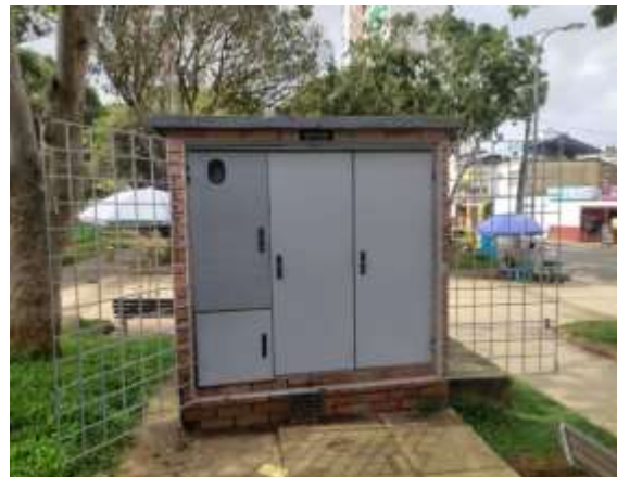
Mantenimiento de tableros
