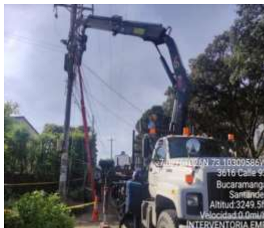
Mantenimiento de transformadores
