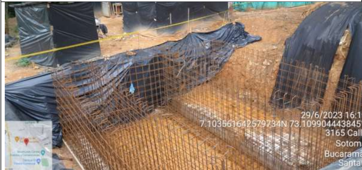
Acero estructural, tanque de almacenamiento
