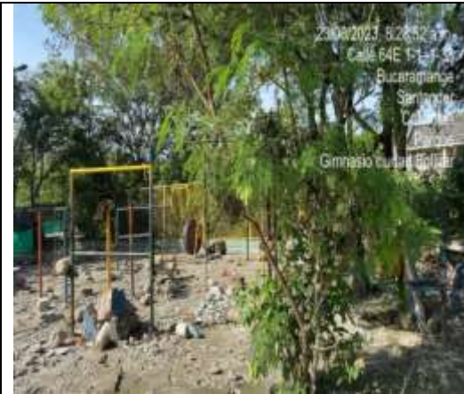
MEJORAMIENTO DEL GIMNASIO EXISTENTE E INSTALACION DE GIMNASIO GRECCO
