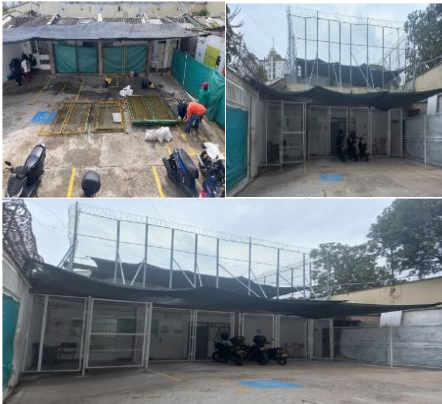
Fotos: intervención de cerramiento para evitar situaciones de inseguridad y riesgo en medida de internamiento CETRA
