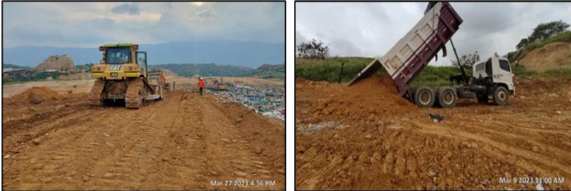
*Ilustración 4 Cobertura de residuos sólidos con material terroso o granular*
