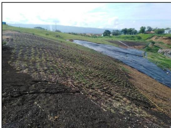
*Ilustración 8 Establecimiento de la capa de orgánica en 2700 m<sup>2</sup> de geocelda en la celda 4*
