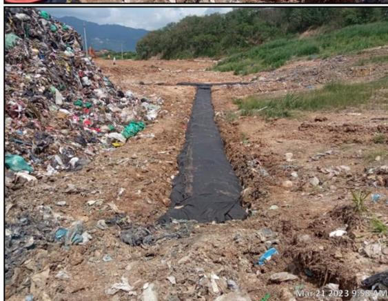
*Ilustración 7 Construcción de filtros*
