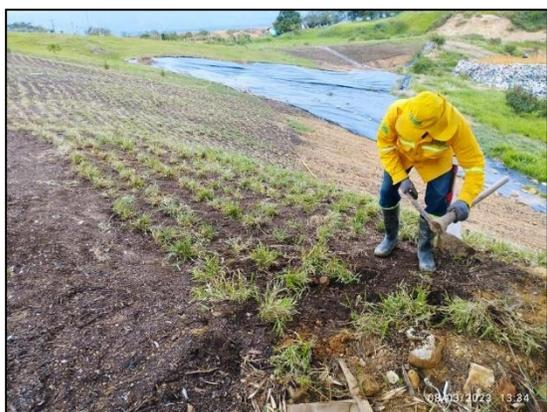
*Ilustración 10 Siembra de gramíneas en el talud de la celda 4*
