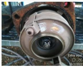
Mantenimiento a la bomba de alimentación a la microfiltración de la DTRO (Por presencia de sedimentos)
