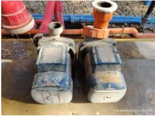
Reemplazo de bomba BR1 por la BR5 en posición B8 (concentrados). Por corto circuito en la bornera
