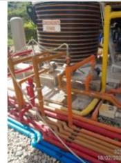
Mantenimiento al tubo floculador del DAF, con solución química para evitar incrustaciones
