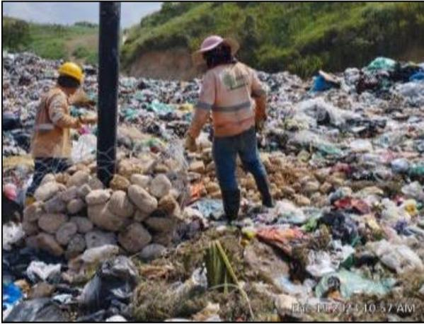
Ilustración 21 Realce de chimeneas celda actual de disposición.
