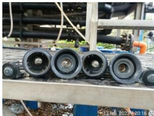
Mantenimiento de accesorios del circuito de recirculación DAF (Cheques, Venturi, mangueras de conducción)
