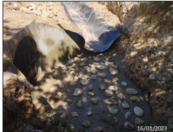
Gráfico 12 Construcción de canales de aguas lluvias
