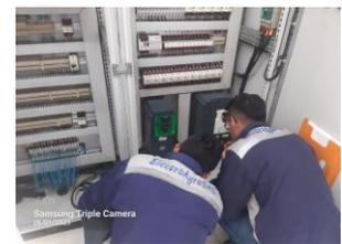
Inspección de la bomba de alta presión Grundfos (Verificación de parámetros de operación eléctricos del motor)
