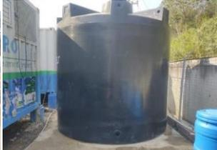
Reemplazo del tanque de 20m3 alimentación DTRO (Por fisura en existente)
