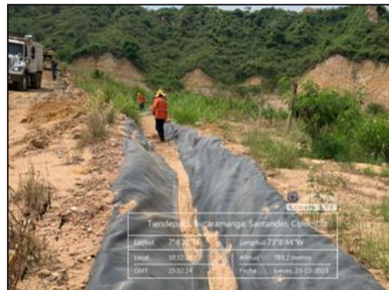
Ilustración 6 Limpieza de los canales de aguas lluvias
