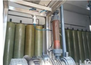
Limpeza de los tramos de succión y descarga de la bomba #7 (para remoción de incrustaciones)
