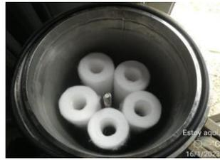
Mantenimiento y Reemplazo de las membranas de la unidad de microfiltración.
