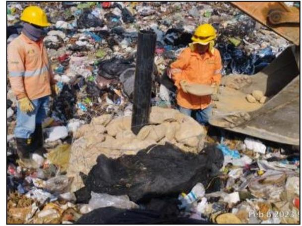
Ilustración 24 Realce de chimeneas celda actual de disposición.
