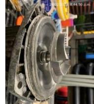
Reemplazo del sello mecánico de la bomba BR2 en posición B1 (por desgaste en sus caras)
