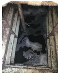
Limpieza de tanques de almacenamiento interno de la DTRO (feed tank y tanque de permeado) (para remoción de materia orgánica y lodo)
