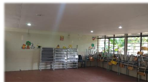
Adaptación de aulas por abrir- IE INEM.
