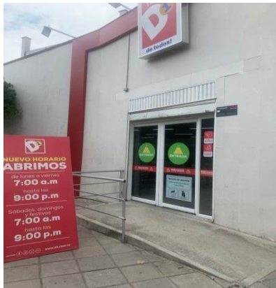
RAMPA DE ACCESO-TIENDA D1-DIAMANTE 2
