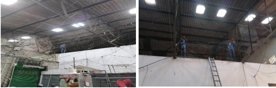
*Fotos – adecuaciones en plazas.
