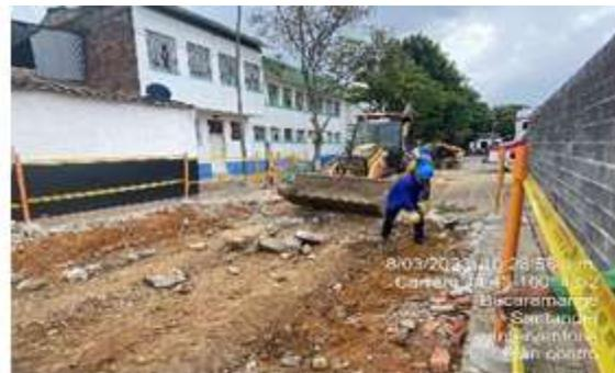
*Demolición de pavimento asfáltico y retiro de escombros*
