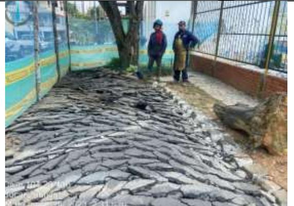
Corte y demolición de pavimento asfáltico
