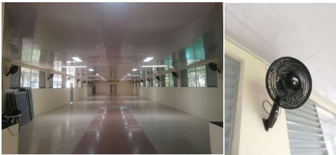
Suministro e instalación de mobiliario ventilador de pared
