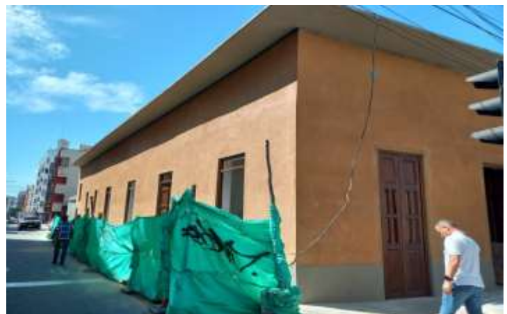
FACHADA POR LA CARRERA 25
