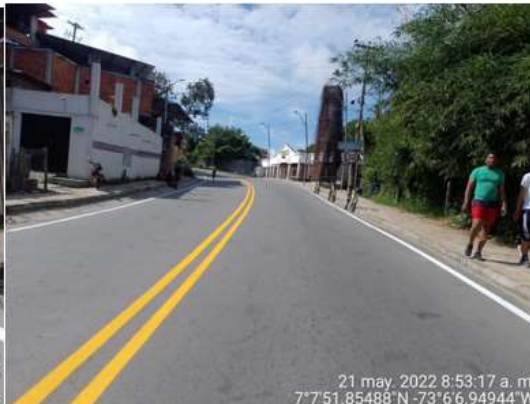
SECTOR MORRORICO TRAMO 2. SEÑALIZACIÓN
