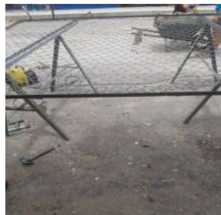
CERRAMIENTO CANCHA DESPUES
