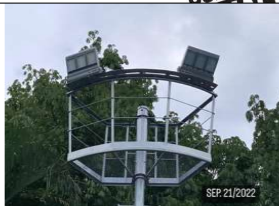
Instalación reflectores (Inst. eléctricas)
