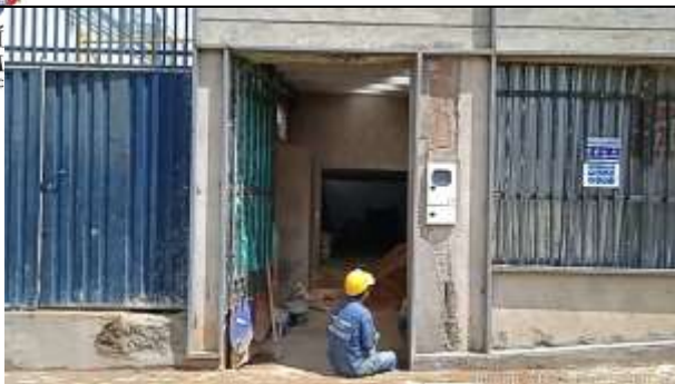
Instalación de Contador Eléctrico. Septiembre 30 de 2022
