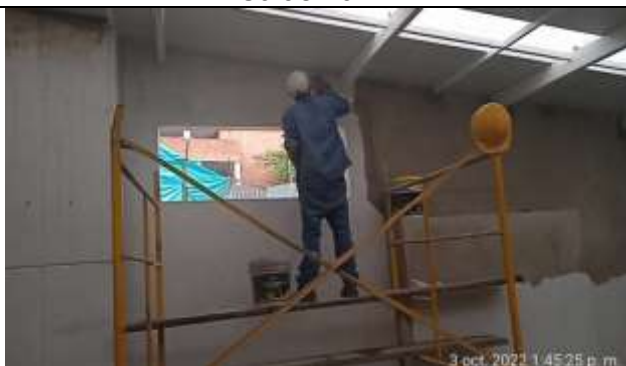
Estuco sobre muros. Octubre 3 de 2022
