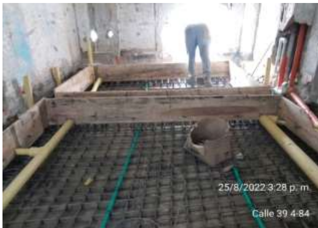
PLACA TERCER NIVEL ANTES
