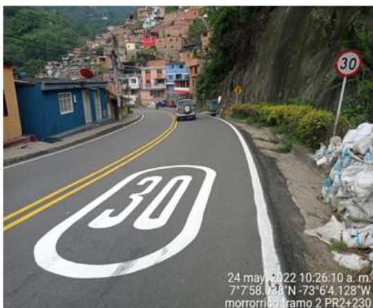
SECTOR MORRORICO TRAMO 2. SEÑALIZACIÓN
