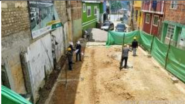
Vista panoramica de las Obras. Septiembre 26 de 2022
