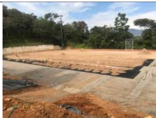
AHORA: Vista trabajos en la cancha
