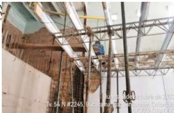
Trabajos en la estructura. Lunes 3 de Octubre de 2022
