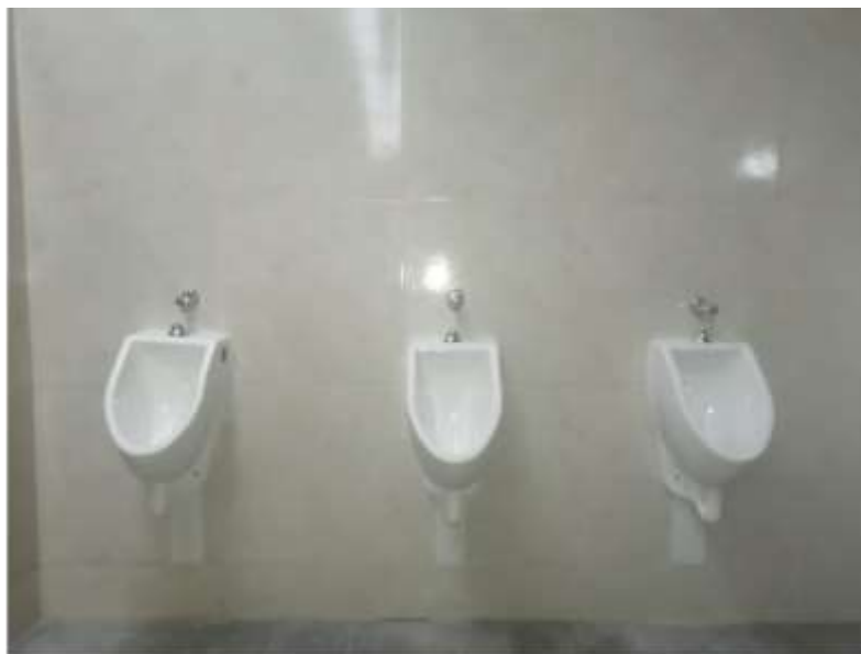
Suministro e Instalación de orinales uso institucional para baños centrales
