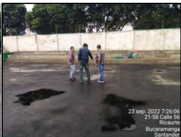
IE AURELIO MARTINEZ SEDE B - DESPUES
