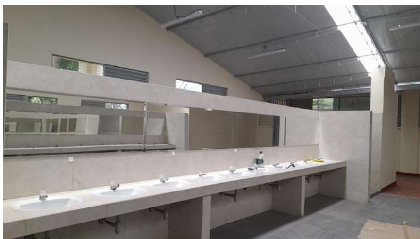
Suministro e Instalación de espejos biselados 4mm
