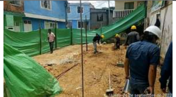
Vista panoramica de las Obras. Septiembre 26 de 2022
