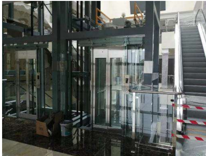
INSTALACION DE ASCENSOR PANORAMICO
