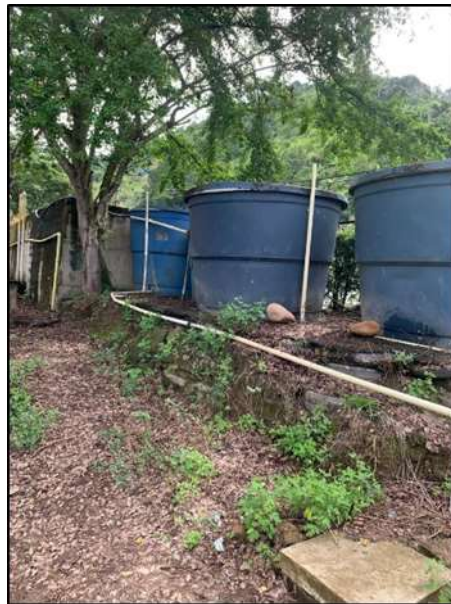
Registro de los tres tanques a construir base en concreto
