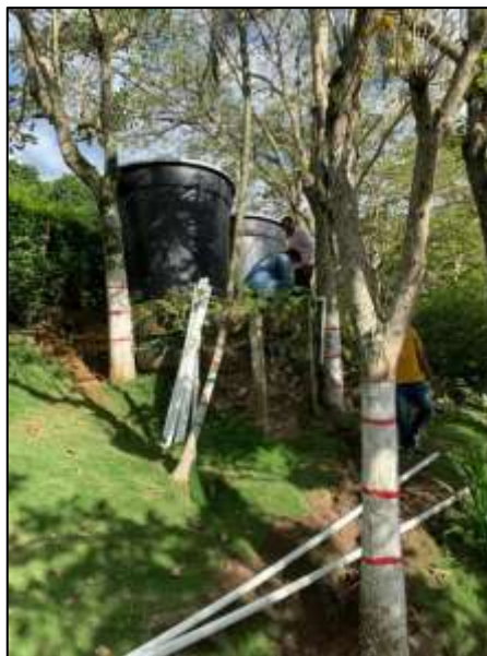
Registro de los dos tanques plásticos a reubicar construir base en concreto
