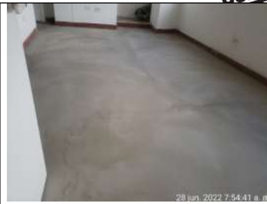
APLICACIÓN DE MASTICO POLIMÉRICO DE NIVELACIÓN
