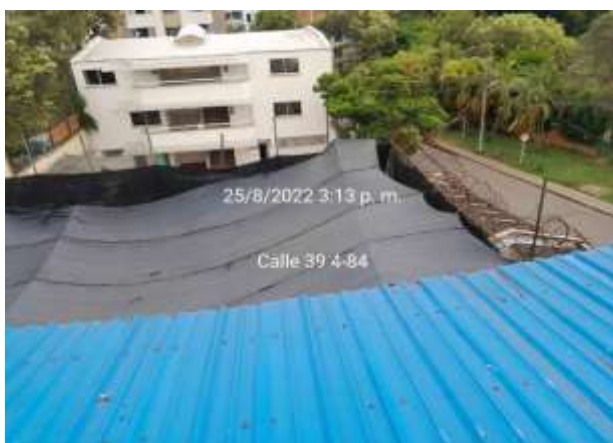
CERRAMIENTO CANCHA ANTES
