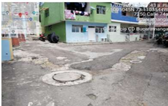
BARRIO SAN PEDRO CALLE 73 CON CR 29 A – ANTES
