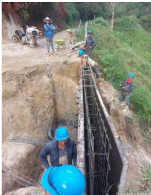
Punto 9. Construcción alcantarilla y cunetas Via al Prado cerca a finca Señor Raimundo Corregimiento 1
