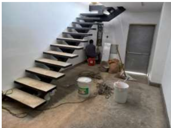
ACCESO MEZANINE Y SALIDA DE EMERGENCIA
