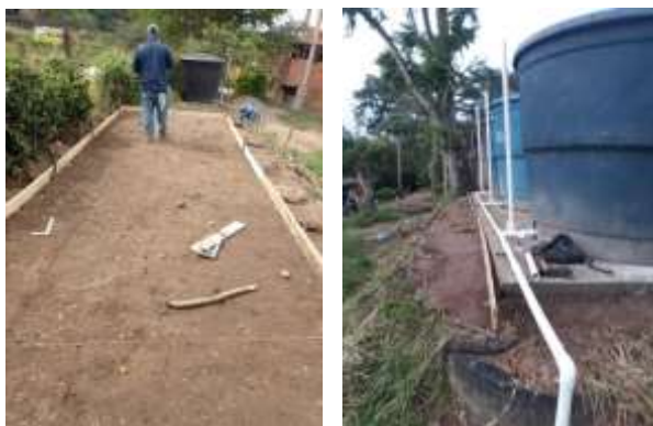
Registro del proceso de instalación de tubería
