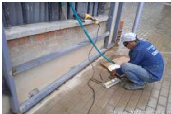
Instalación de Fachada. Septiembre 26 de 2022
