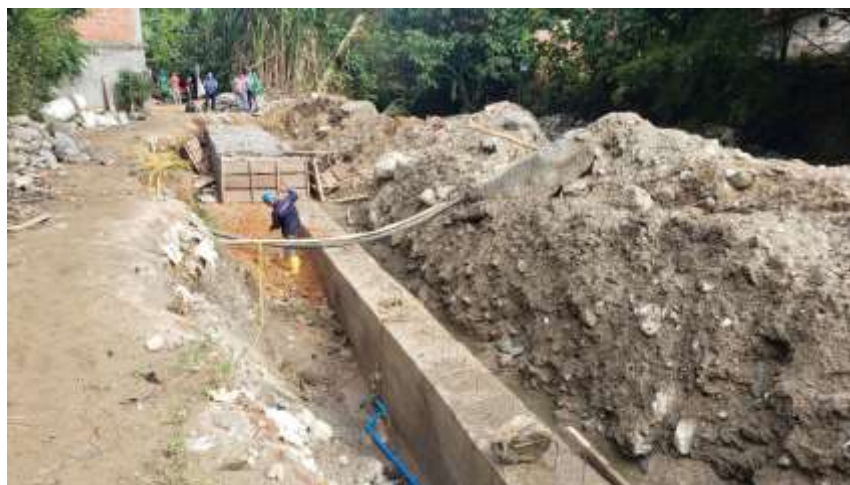
Punto 1. Construcción muro de gaviones Quebrada La Jabonera: Entrada La Vega (Antes del puente) Familia Omaira Meneses - Vereda Vijagual - Corregimiento 1
