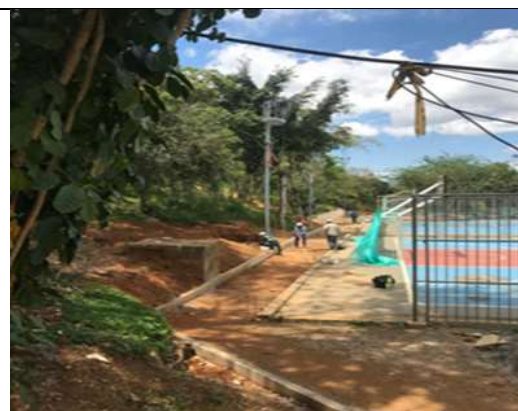
AHORA: Construcción bordillo nivelación base sendero principal a la cancha
