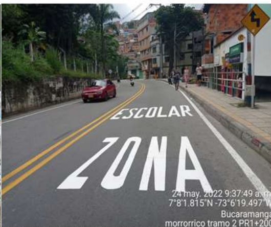
SECTOR MORRORICO TRAMO 2. SEÑALIZACIÓN
