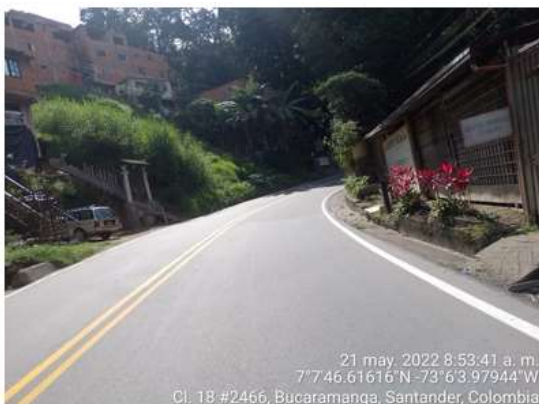
SECTOR MORRORICO TRAMO 2. SEÑALIZACIÓN
