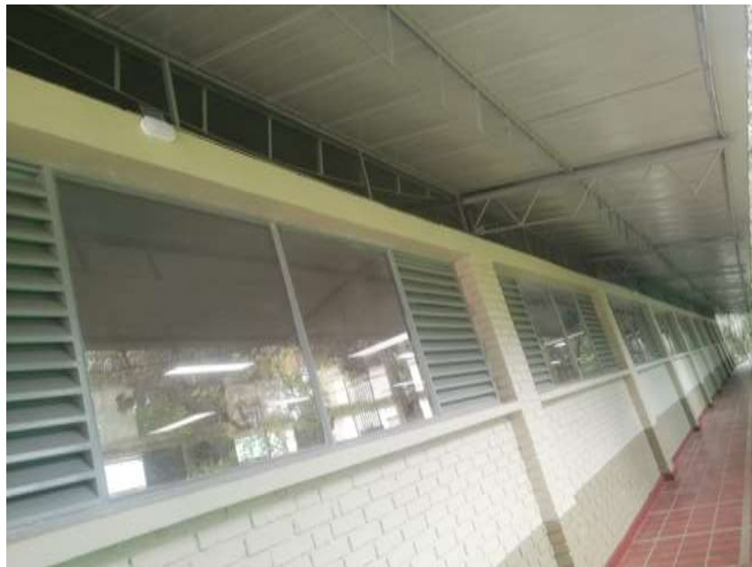
Suministro e Instalación de Tortugas
