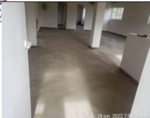
APLICACIÓN DE MASTICO POLIMÉRICO DE NIVELACIÓN
