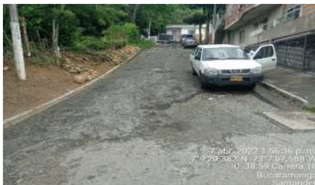
BARRIO OLAS BAJAS CALLE 21N # 17ª-20 ANTES
