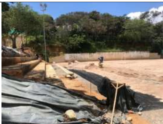
AHORA: Trabajos en la cancha
