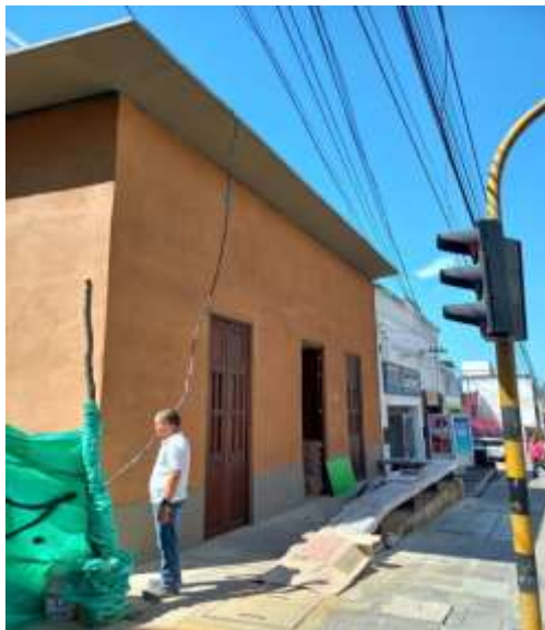
FACHADA POR LA CALLE 36
