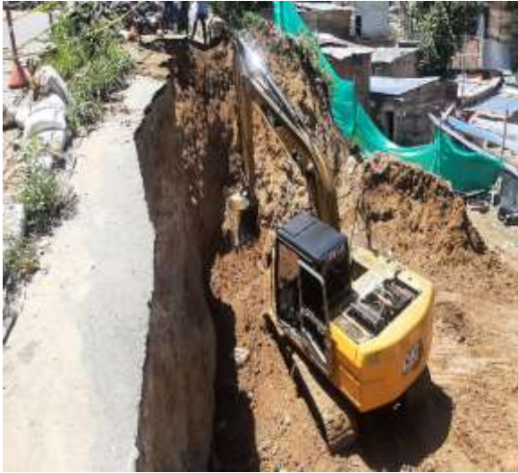
Punto 17. Construcción de muro de contención fallo banca via Barrio Villa Helena
