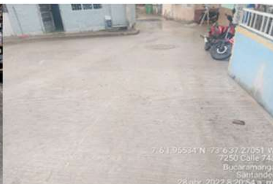
BARRIO SAN PEDRO CALLE 73 CON CR 29 A - DESPUÉS
