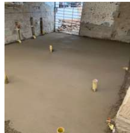
PLACA TERCER NIVEL DESPUES
