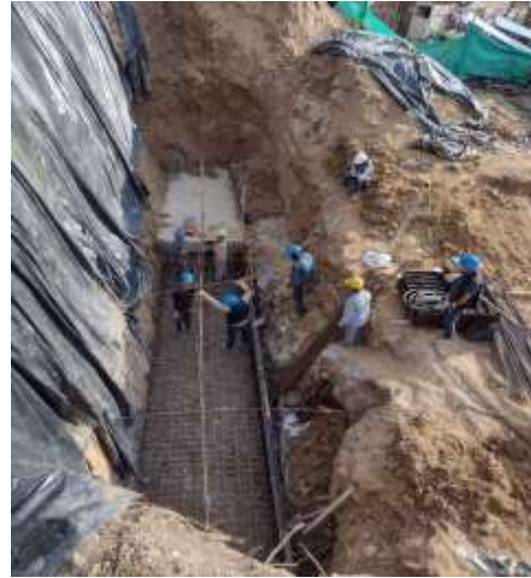
Punto 17. Construcción de muro de contención fallo banca via Barrio Villa Helena
