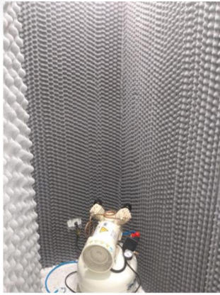
Insonorización de cuartos de compresor en C.S Libertad, Colorados, San Rafael y Rosario.
