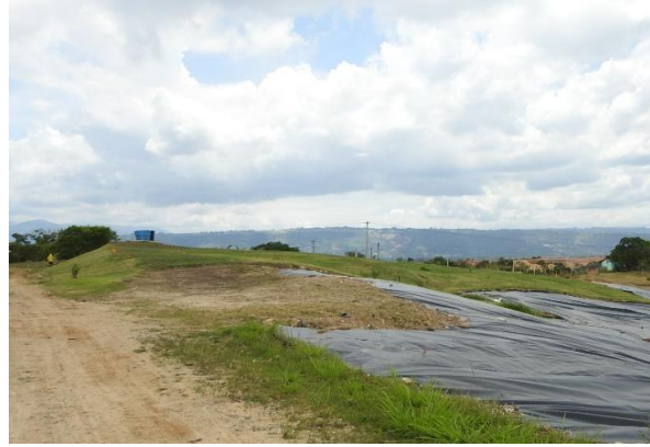
Clausura en la celda 4.
