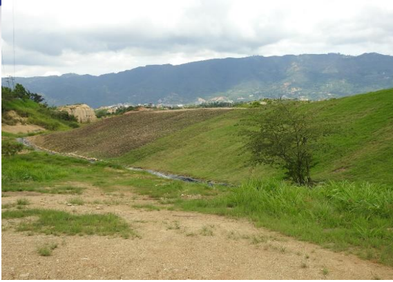
Clausura en la celda 4.
