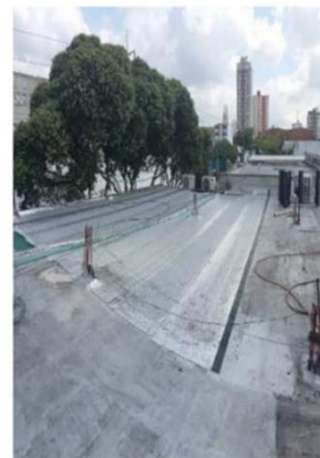
Impermeabilización con manto a calor en un área de 320 mts 2 , los cuales abarcaron el área administrativa (segundo piso) UIMIST.
