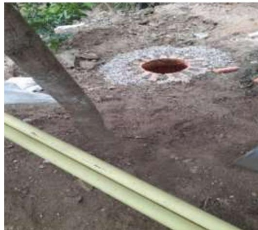
**Pozo de infiltración altura 3 metros**
