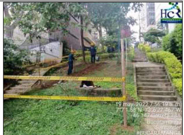
CARRERA 48A CON CALLE 46 apertura en tierra para instalación de banco de ductos
