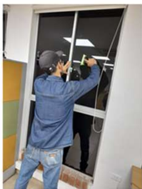
Ilustración 13 Instalación Película Protección Solar.
