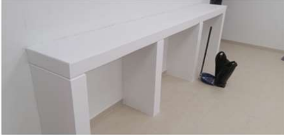
Ilustración 7 Detalle Mesón en Concreto y Mampostería.
