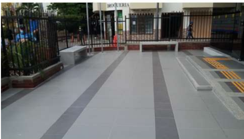
Ilustración 2 PLAZOLETA DESPUES DE SER INTERVENIDA
