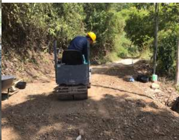
Conformación de la Capa de Base Granular
