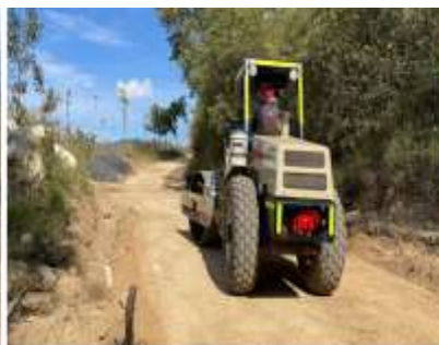
Compactación de la subrasante
