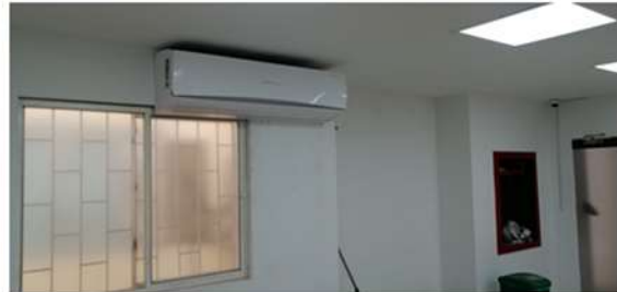
Ilustración 10 Detalle Aire Acondicionado 36000 Btu
