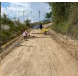
Nivelación de la capa de base granular
