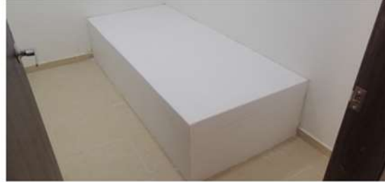
Ilustración 8 Detalle Camas en Cuartos en concreto y mampostería.
