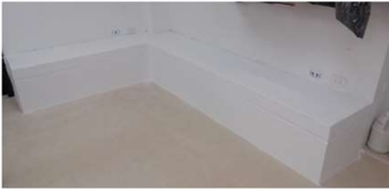
Ilustración 9 Detalle de Bancas en Concreto y Mampostería.
