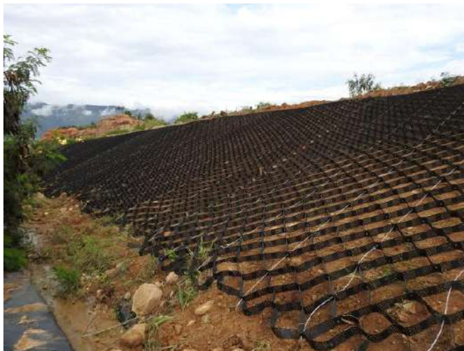
Instalación de 900 m 2 de geocelda en el talud de la celda 1
