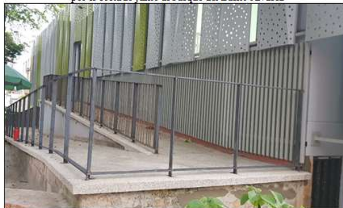
Adecuación de rampa de acceso, por el costado junto al Parque del Barrio Alvarez
