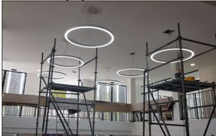
Hall principal: Instalación de luminarias
