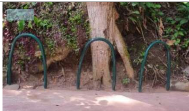
Instalación de protectores de árboles.
