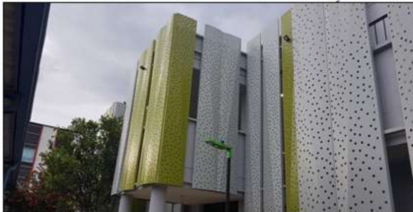
Vista Fachada de Acceso- revestimiento lámina aluzinc y celosía
