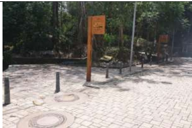
Instalación de señalética.
