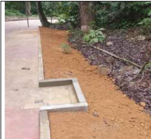
Relleno de material Prestamo
