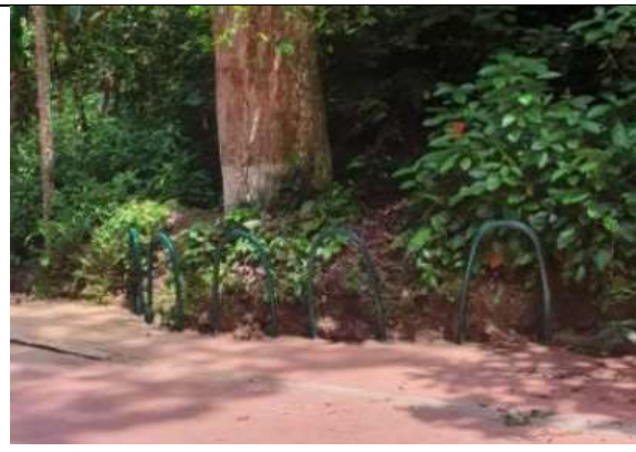
Instalación de protectores de árboles.
