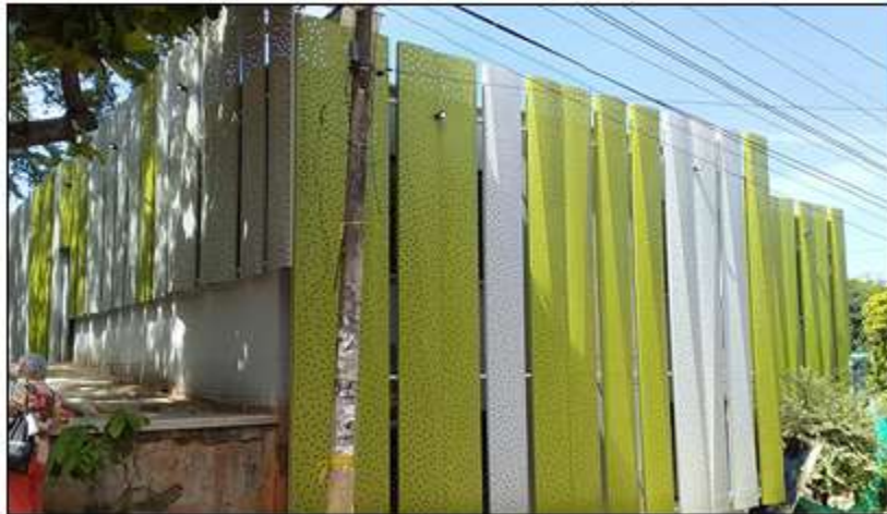
Vista Fachada - Revestimiento Lámina Aluzinc
