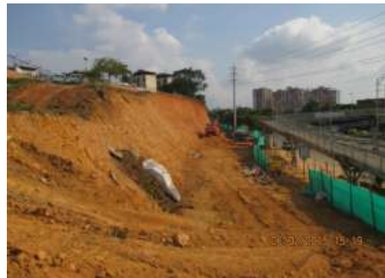
Foto No. 2 Excavación del lote Corinco, frente a Estación El Diamante Metrolínea
