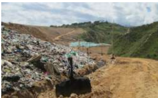
Prolongación de chimeneas (Gaviones Parados)
