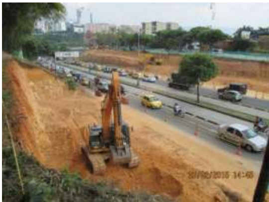
Foto No. 1 Actividades de excavación realizadas en Parque de las Hormigas y talud de Conucos.
