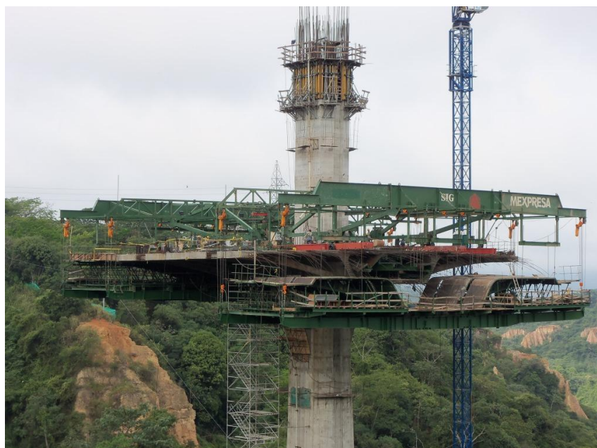
Foto 3. Descenso y avance de encofrado de tablero en Dovela Uno Delantera (Norte) en Frente de Pila 3.
