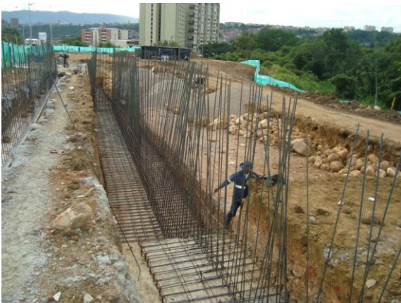
CONSTRUCCION DE MUROS DE CONTENCIÓN
