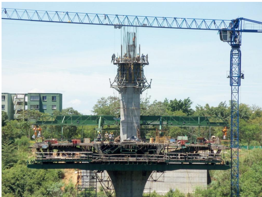
Foto 2. Armado de quinto trepado en Torre 3.
