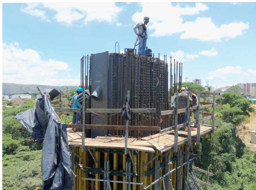
Foto 6. Detalle de encofrado para revestimiento de concreto para cajones T0 y T1. Cajón T2 en proceso de soldadura a T1.
