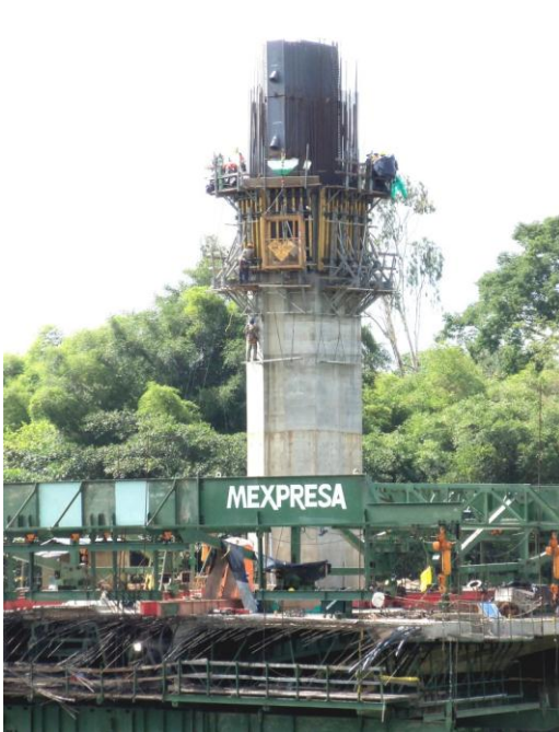
Fotos 4 y 5. Izaje y posicionamiento de cajones metálicos T0, T1 y T2 en Torre 2. Vistas en los costados sur y norte respectivamente.
