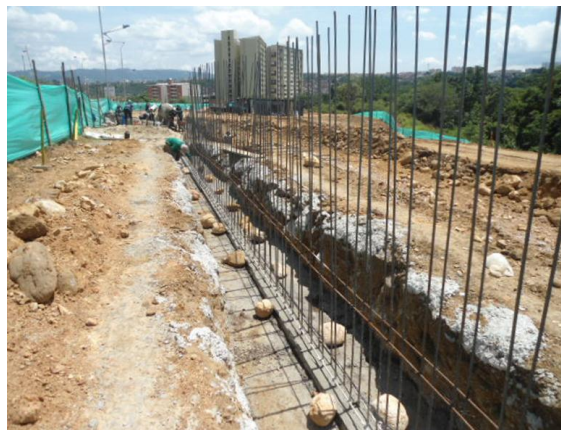
CONSTRUCCION DE MUROS DE CONTENCIÓN
