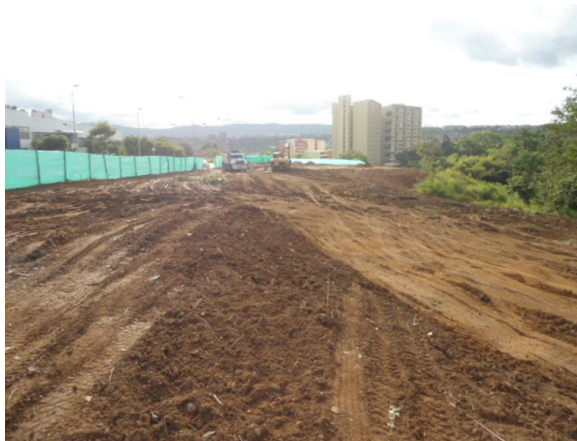
CERRAMIENTO, LIMPIEZA INICIAL Y DESCOPODE LA TOTALIDAD DEL AREA DE PROYECTO
