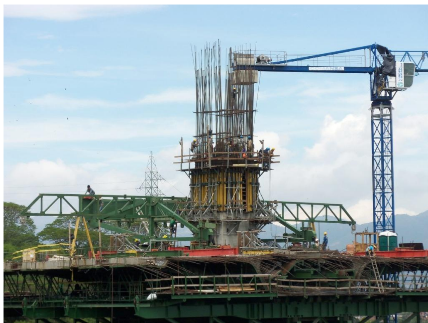
Foto 1.. Izaje para segundo trepado de formaleta Doka en Torre 3. Inicio de montaje de viga posterior de estructura superior de Carro de avance Sur en Frente de Pila 3.
