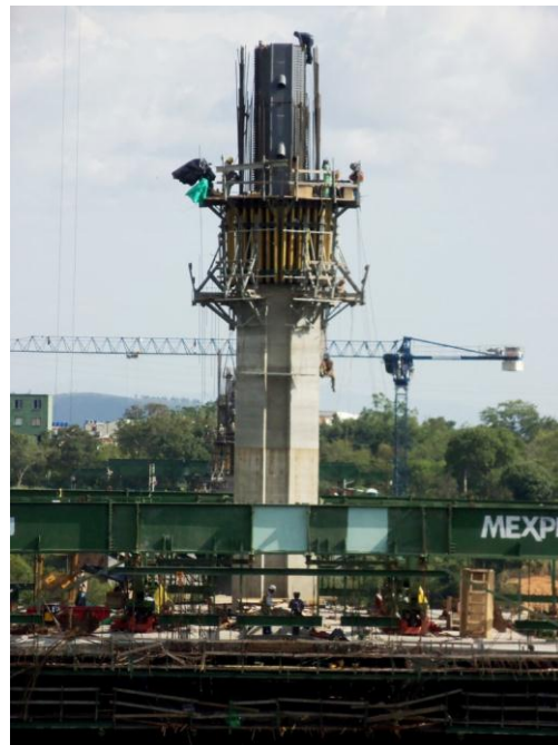
Fotos 4 y 5. Izaje y posicionamiento de cajones metálicos T0, T1 y T2 en Torre 2. Vistas en los costados sur y norte respectivamente.
