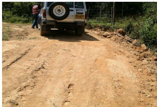
Evidencias de material aplicado en zanjas y relleno sobre sectores de la vía afectados por el agua lluvia.
