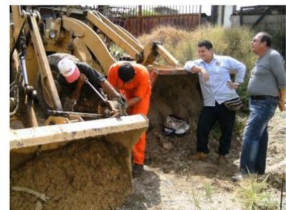
DESMONTE DE ELEMENTOS DE TRANSMISION DELANTERA IZQUIERDA, EJE ARTICULADO
