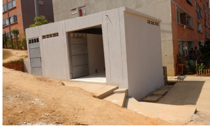
OBRAS COMPLEMENTARIAS ALTOS BETANIA: CUARTOS DE ASEO Y PASAMANOS ENTREGADAS
