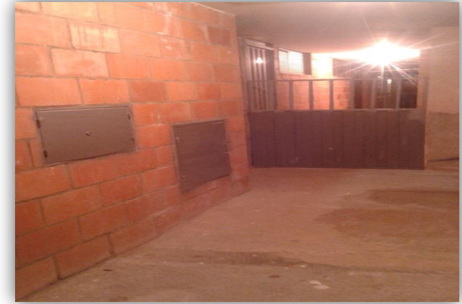
VERIFICACIÓN DE HABITABILIDAD DE APARTAMENTOS EN CAMPO MADRID IDENTIFICADOS COMO ARRENDADOS EN VISITAS ANTERIORES.
