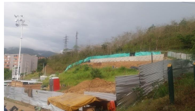
OBRAS DE MITIGACION PARA CONSTRUCCION DE BIBLIOTECA Y CDI CAMPO MADRID
