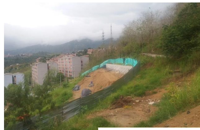
OBRAS DE TRASLADO DE REDES HIDRAULICAS Y PLUVIALES CAMPO MADRID
