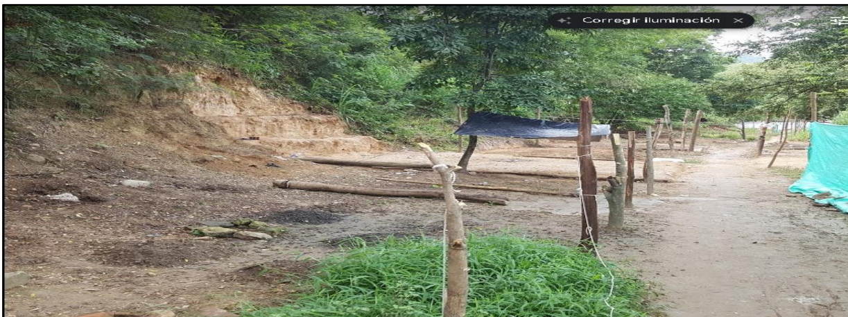
Imagen 3. Evidencia de zona verde antiguas vías ferroviarias en donde se evidencia tala de árboles, descapote vegetación, demarcación y loteo del terreno sobre talud del lugar, (Antes-fecha 17 de junio 2020).
