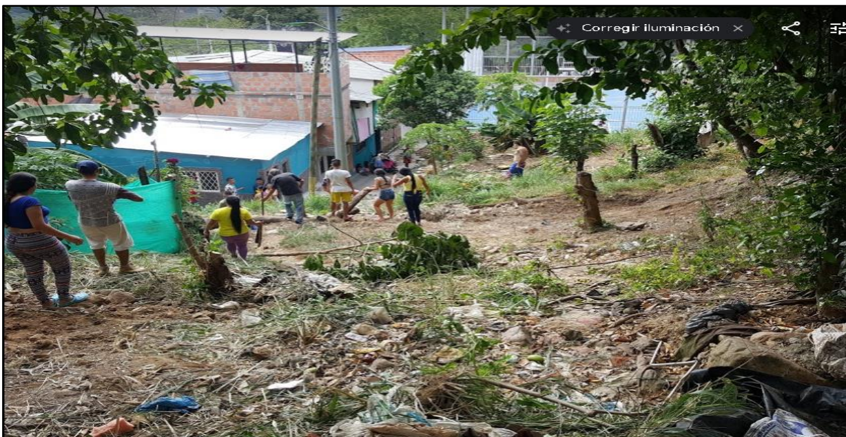
Imagen 7. Labores de descapote tala de árboles y loteo para futura construcción de ranchos por parte de la comunidad del sector Calle 15N entre Cra 27 y Cra 26 asentamiento humano José María Córdoba. (antes-fecha 22 de mayo de 2020).
