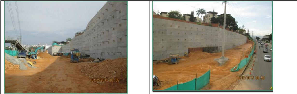
Obras de estabilización del talud de Corinco en pantalla anclada, a la fecha se han construido 2100 metros cuadrados. Se viene realizando el replanteo y conformación de la subrasante.
