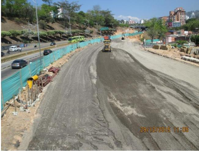
Instalación de base para construcción de carril de metrolínea entre las abscisas K0+610 a K0+810 e Instalación de Subbase en carriles mixtos.
