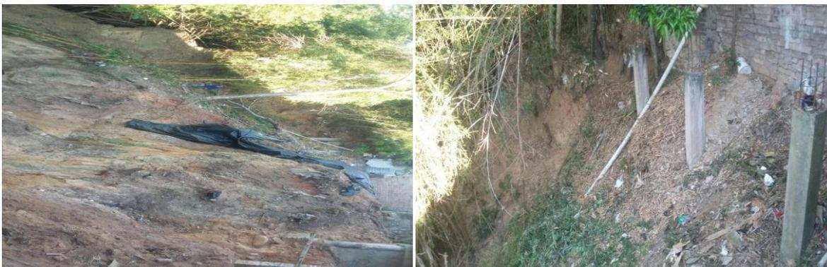
Trabajos realizados: Descapote y Limpieza del Talud
