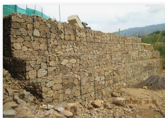
Construcción de muro de gaviones para contención del talud y posicionar la maquina piloteadora, 100% ejecutado.
