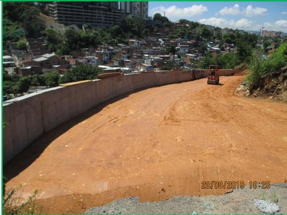
Relleno estructural Muro No.2 del eje 18 de la vía al Barrio Nueva Granada entre abscisas k0+750 a k0+800, se construyó 50 metros de muro de contención.
