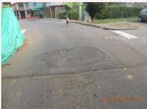
Antes de la Intervención
