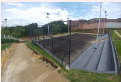
Mantenimiento cerramiento y pintura de Graderías
