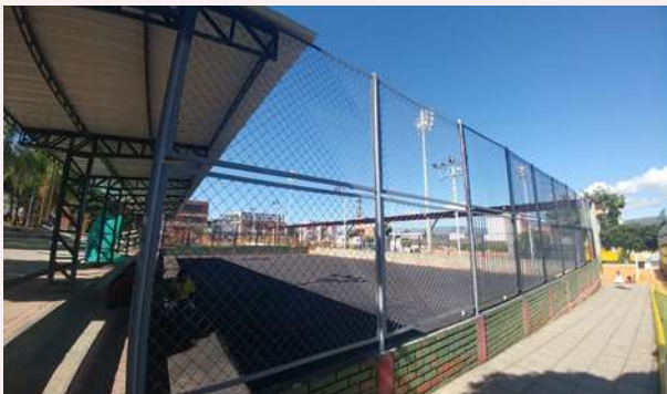
Mantenimiento de mallas – Cubierta gradería
