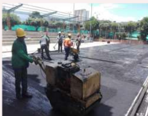
Aplicación de Asfalto en caliente, Mantenimiento de cubierta, pintura graderías
