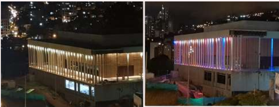
Fachada Gran Salón – Centro de Convenciones
