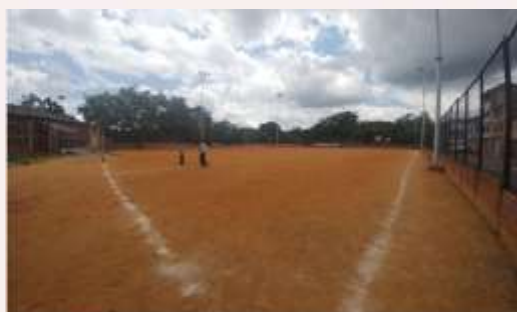
Nivelación y conformación - Relleno compactado
