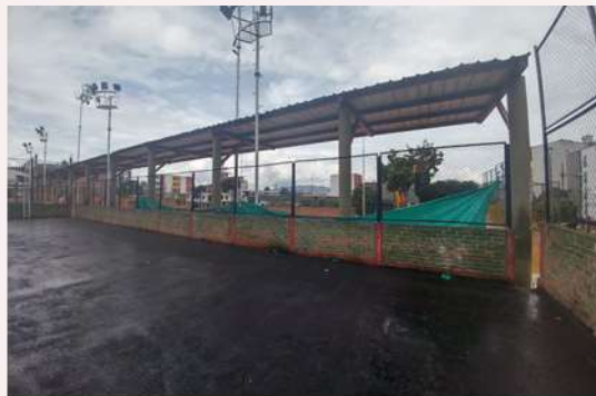
Aplicación de Asfalto en caliente
