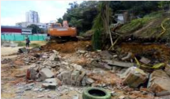
Demolición de Muro de Cerramiento existente
