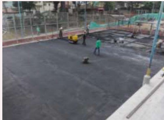
Aplicación de Asfalto en caliente y mantenimiento De módulos en malla
