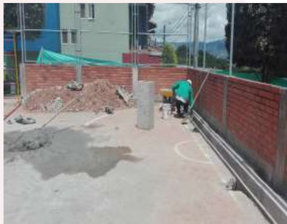
Construcción canaleta aguas lluvias
