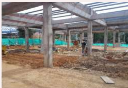
Instalaciones sanitarias y cuchillas de cubierta
