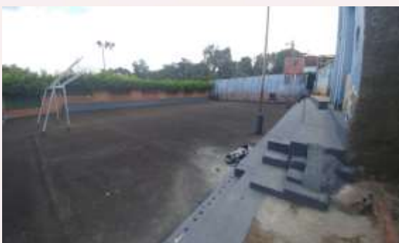
Aplicación de Asfalto en caliente y Pintura gradería- Canaleta
