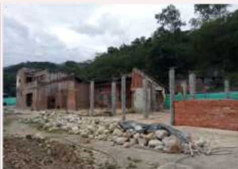
ESTRUCTURA NUEVA DEL COSTADO SUR
