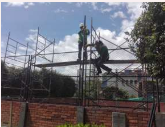
Mantenimiento de mallas
