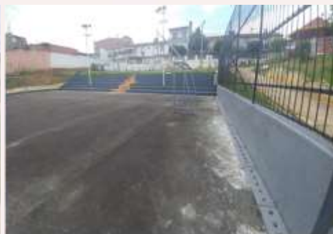
Aplicación de Asfalto en caliente Pintura de muros - Canaleta
