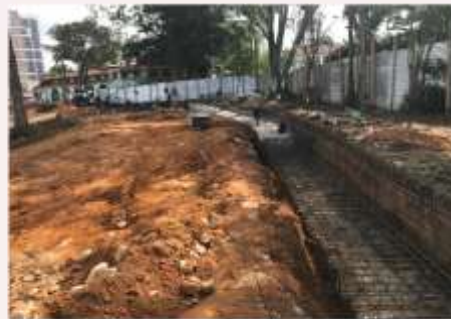
Construcción de Muro de Contención
