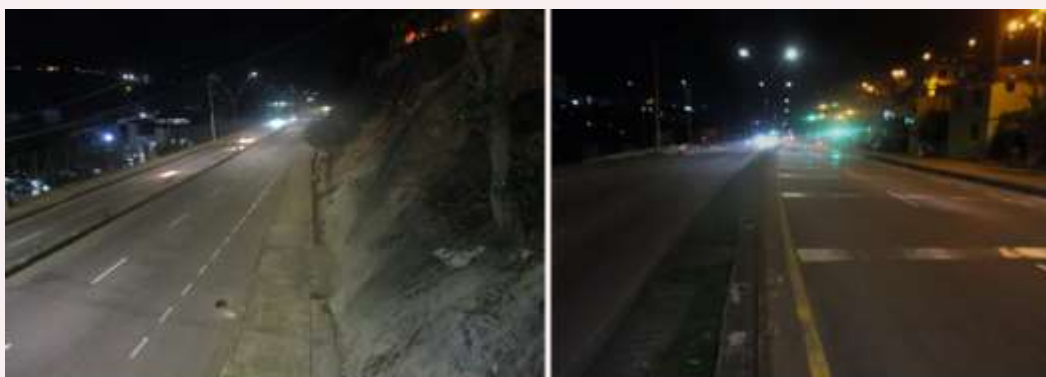
ALUMBRADO LED VIA CENFER – PUERTA DEL SOL ENCENDIDO Y TELEGESTIONADO Y CON MEDIDOR DE ENERGIA EXCLUSIVO
