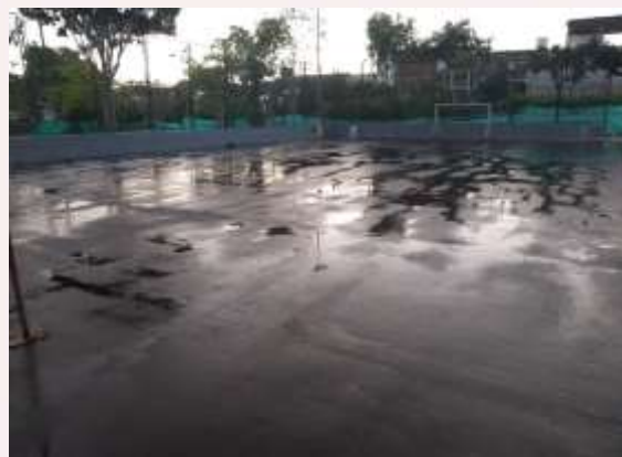
Aplicación de Asfalto en caliente y Mantenimiento de mallas
