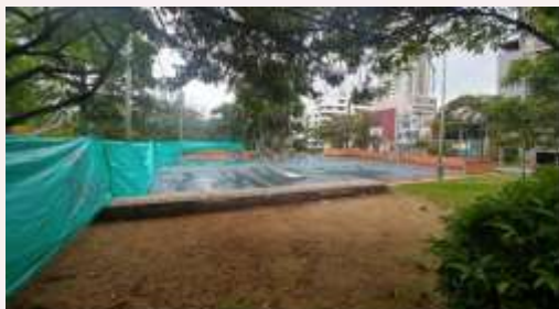
Adecuaciones Muro y acceso a cancha Costado occidente cancha basquetbol
