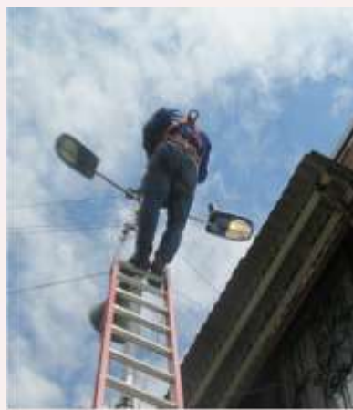
Mantenimiento alumbrado público barrio Morrarrico
