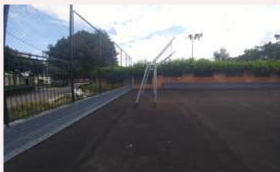
Mantenimiento y pintura de mallas y Modulo rejas-pintura muros
