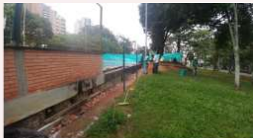
Construcción canaleta aguas lluvias
