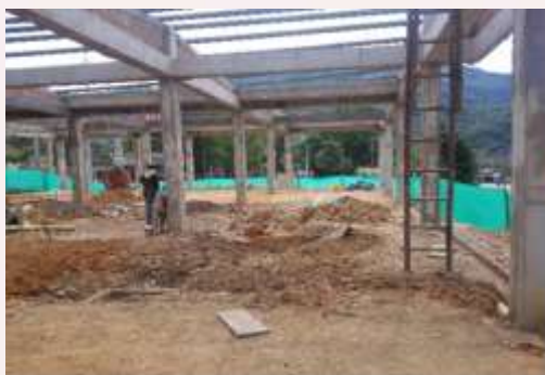
Estructura en pórticos terminada
