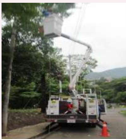
Mantenimiento alumbrado público barrio el Kennedy
