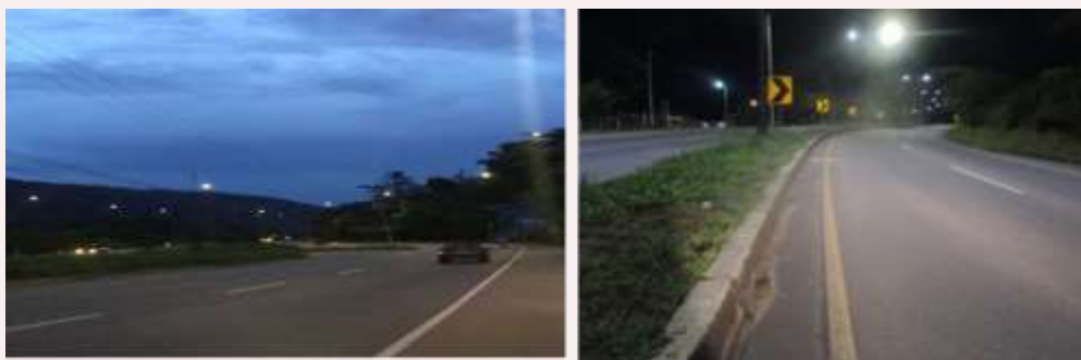
ALUMBRADO LED CENTRO-ABASTOS ENCENDIDO Y TELEGESTIONADO Y CON MEDIDOR DE ENERGIA EXCLUSIVO
