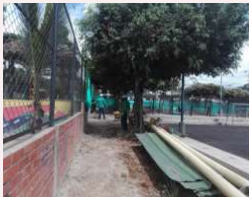
Demolición de andenes, pintura malla
