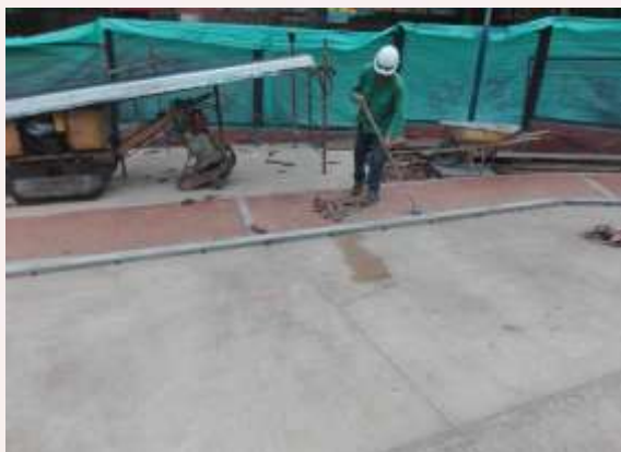
Bordillo confinamiento, piso en adoquín
