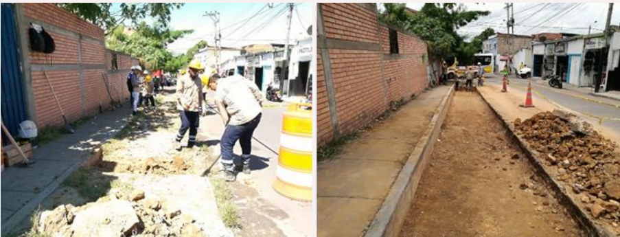
Vías internas del barrio Pablo VI
