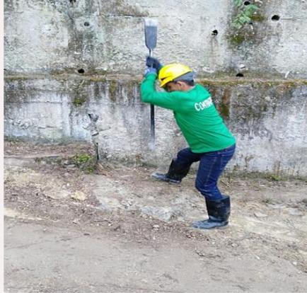
DEMOLICION DE CUNETA EN CONCRETO
