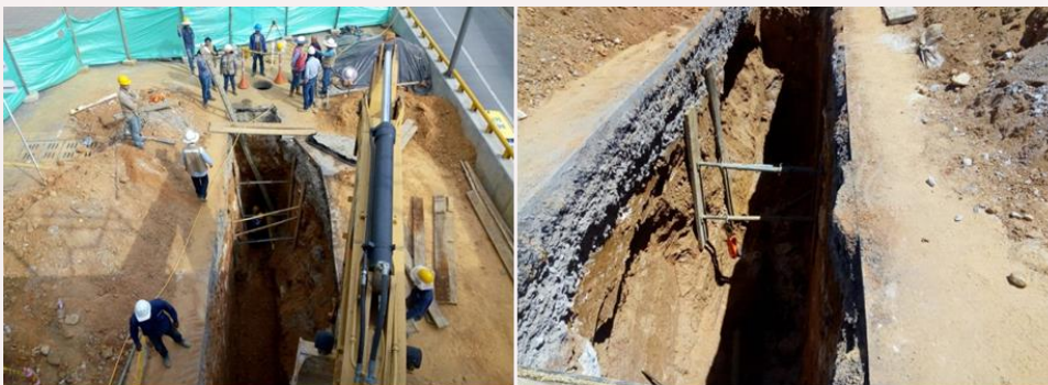
Construcción Muro de Contención
