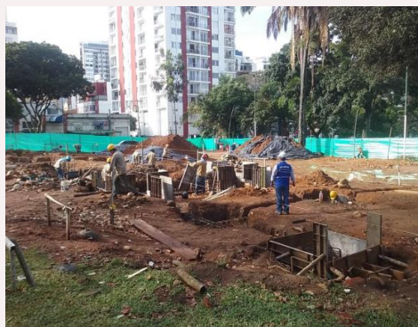
EXCAVACIONES Y ACTIVIDADES DE CIMENTACION EDIFICIO CENTRAL
