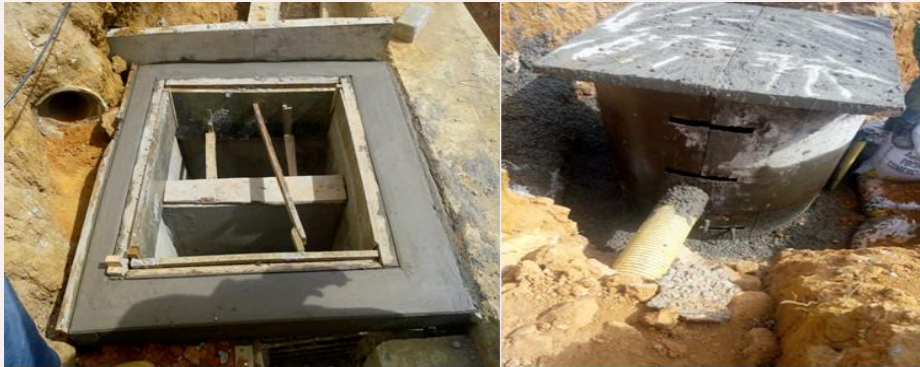
Construcción de Alcantarillado
