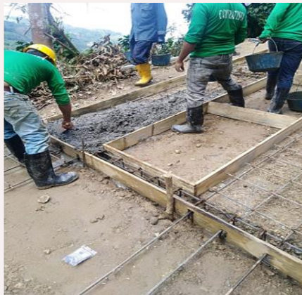
APLICACIÓN DE CONCRETO A FORMALETAS
