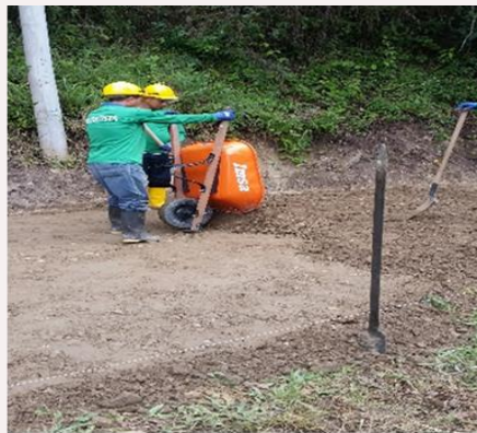
EXTENDIDO Y SUMINISTRO DE LA BASE GRANULAR.
