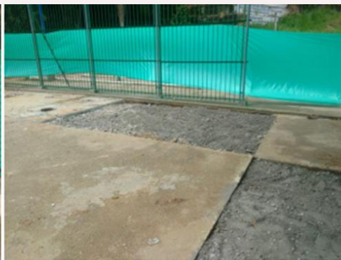
REPOSICIÓN LOSAS DE PISO BARRIO MONTEREDONDO
