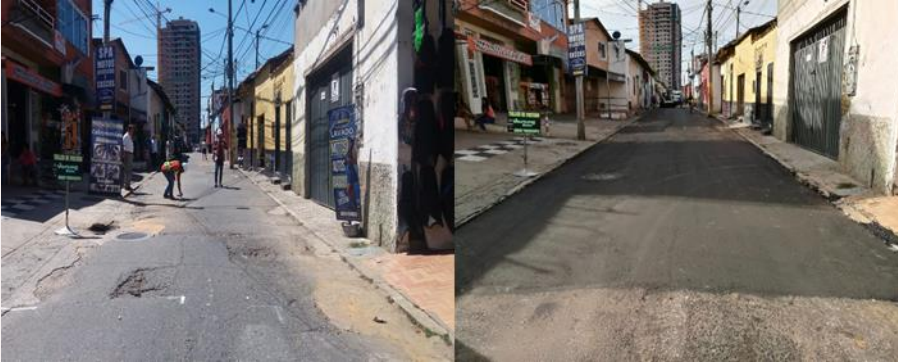
Carrera 18 entre avda La Rosta y calle 55 (fotos antes izq. y después der.)
