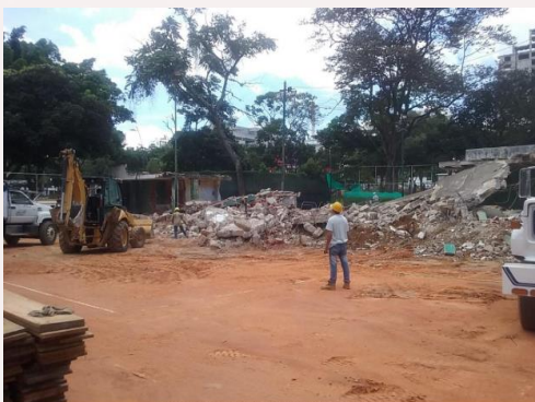
DEMOLICIÓN A MAQUINA EDIFICIO ANTIGUO
