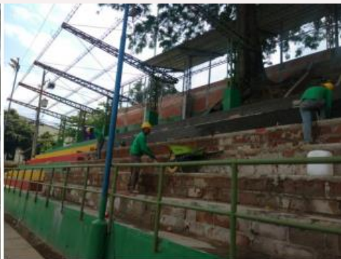
ARREGLO GRADERIAS BARRIO KENNEDY
