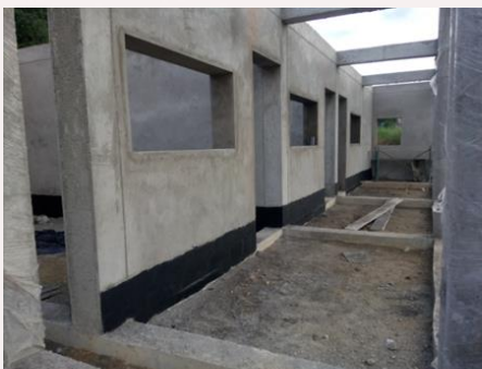
COSTADO SUR DE LA LUDOTECA
