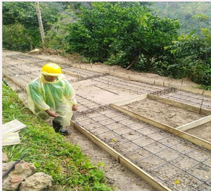
INSTALACION DE FORMALETAS PARA HUELLAS
