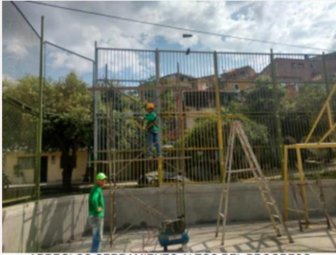
ARREGLOS CERRAMIENTO ALTOS DEL PROGRESO
