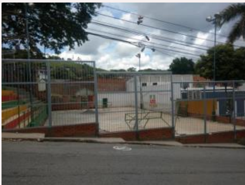
ARREGLO CERRAMIENTO BARRIO KENNEDY
