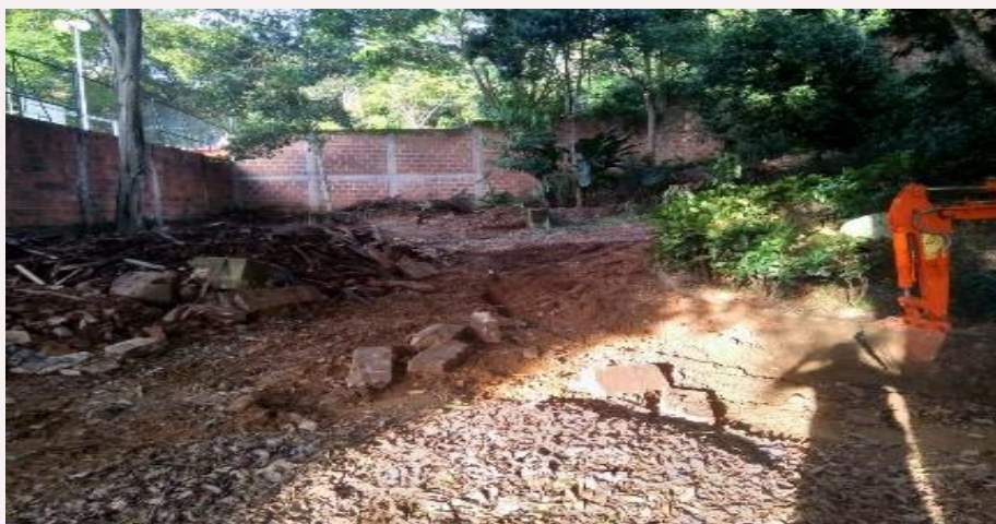
Exploración del Sitio para la construcción
