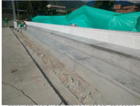
RECONSTRUCCIÓN GRADERIAS ALTOS DEL PROGRESO
