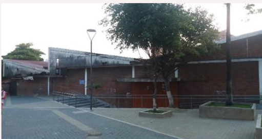
Estado Inicial Cubierta y Fachada
