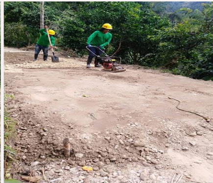
REGADO Y COMPACTACION DE BASE GRANULADA.
