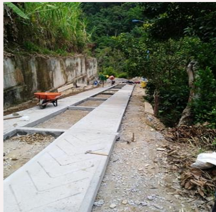
FUNDICION DE CONCRETO PLACA HUELLAS
