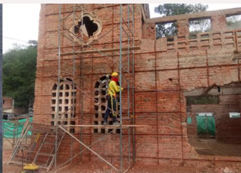
ESTRUCTURA NUEVA DEL COSTADO SUR
