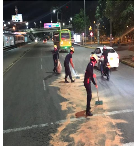
control en riego de aceite
