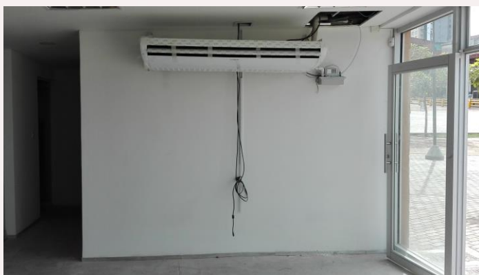
CONSTRUCCIÓN DE ESCOTILLA DE INSPECCIÓN (0.60 X 0.60 M) EN CIELORRASO DE DRYWALL
