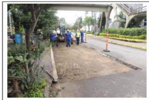
FOTO EXCACION PARA REPARACION PAVIMENTO
