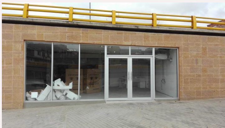
PUERTA PIVOTANTE A DOS HOJAS EN CRISTAL 6 MM TEMPLADO Y MARCO EN ALUMINIO.
