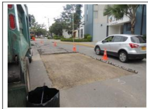
FOTO EXCACION PARA REPARACION PAVIMENTO
