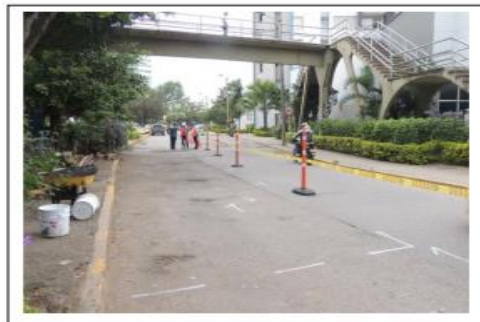
FOTO ANTES DE LA INTERVENCION
