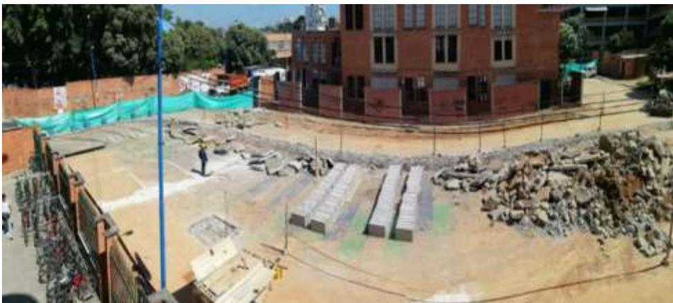
DEMOLICIONES PARA TENDIDO DE DUCTOS SISTEMA ELÉCTRICO Y CONSTRUCCIÓN DE CAJAS DE HALADO.
