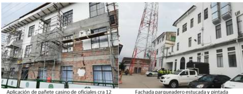
Aplicación de pañete casino de oficiales cra 12
