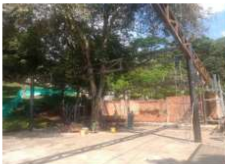
ESTRUCTURA METÁLICA CUBIERTA COMEDOR
