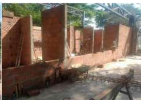
MAMPOSTERÍA AREA DE COCINA
