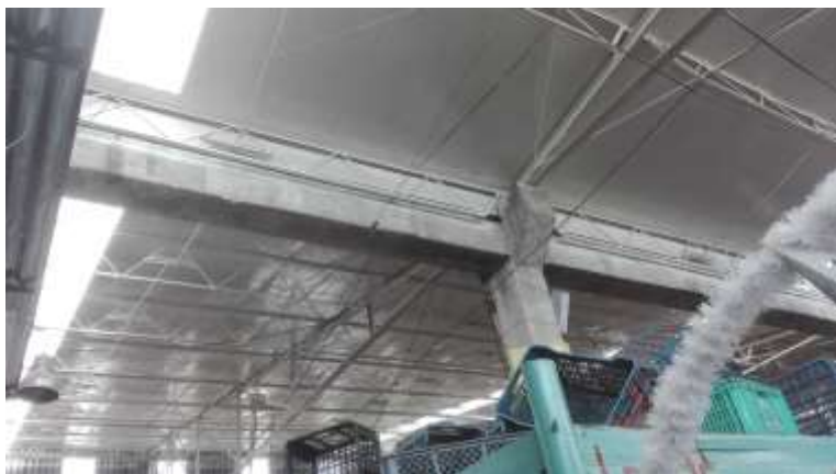
CUBIERTA COSTADO NORTE DE LA PLAZA GUARÍN, INTERNA
