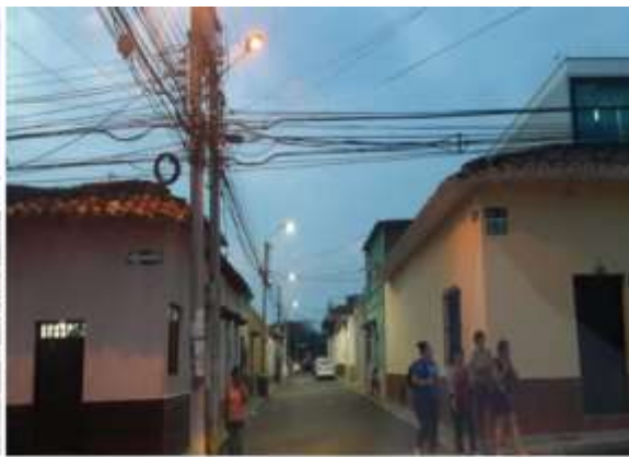
CALLE DEL BARRIO ALFONSO LOPEZ MODERNIZADA A LED - PUEDE OBSERVARSE EL CONTRASTE ENTRE LAS TRES LUMINARIAS LED Y LA AMARILLA DE SODIO
