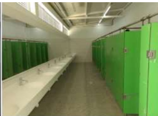
CONSTRUCCIÓN DE LAS BATERÍAS DE BAÑOS (INTERNO) COLEGIO MAIPORE
