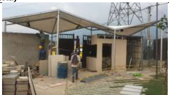
Estado sector portería finales mes de marzo 2019 (Interior IE)
