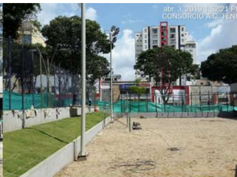
TERMINACION CANCHA COSTADO ORIENTAL
