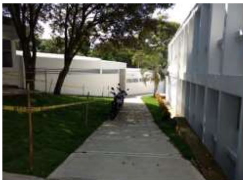
CONSTRUCCION BATERIAS DE BAÑOS (EXTERNO) COLEGIO MAIPORE
