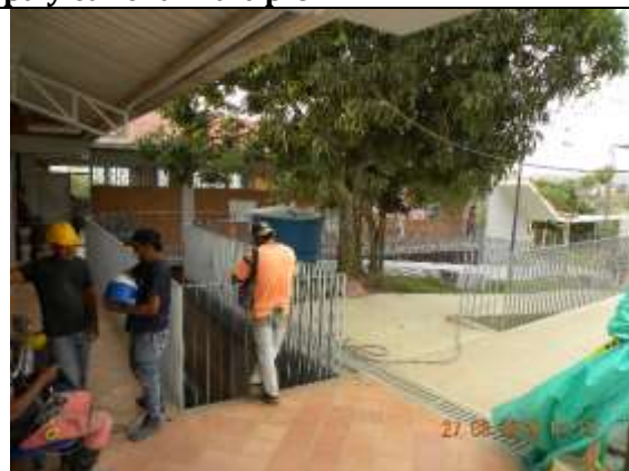
Estado conexión rampa finales mes de marzo 2019 (interior IE)
