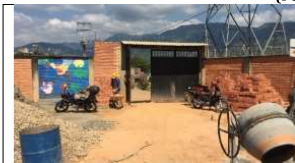
Estado sector portería inicios mes de enero 2019 (Interior IE)
