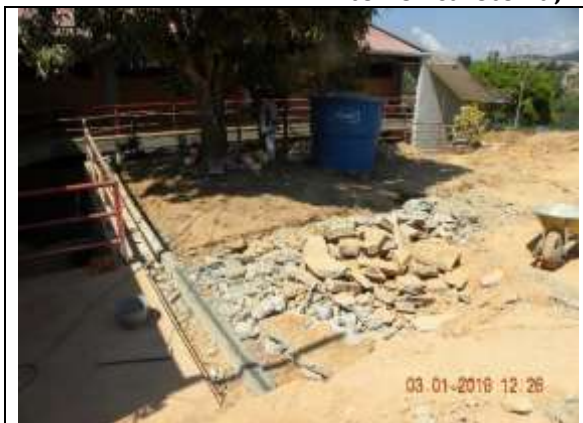
Estado conexión rampa inicios mes de enero 2019 (exterior IE)
