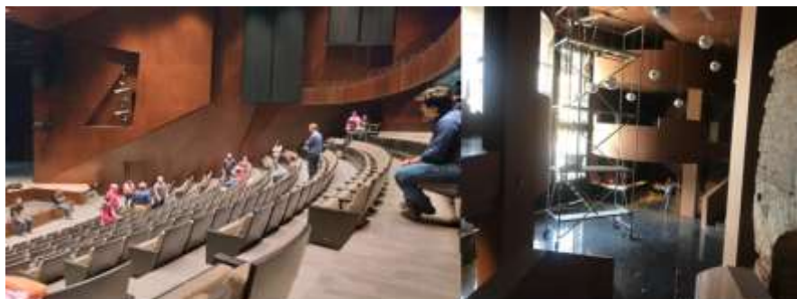
Terminación de la Instalación de silletería
