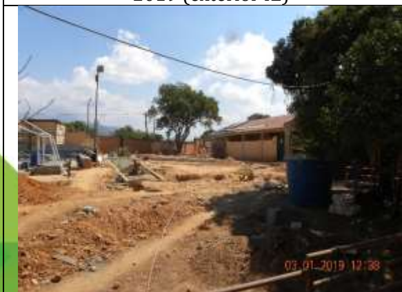
Estado rampa gradería tarima inicios mes de enero 2019 (exterior IE)
