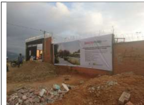
Estado sector portería finales mes de enero 2019 (exterior IE)
