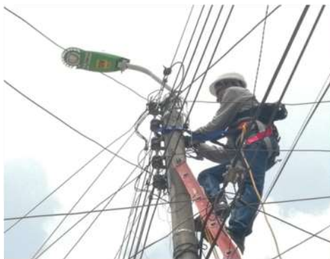
TECNICO CAMBIANDO LUMINARIA A TECNOLOGIA LED USANDO ELEMENTOS DE SEGURIDAD
