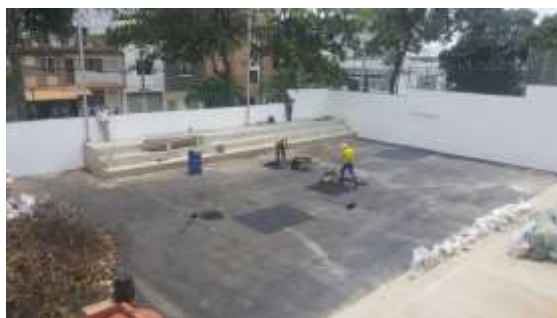
Tratamiento de zonas deprimidas en el asfalto patio 1.
