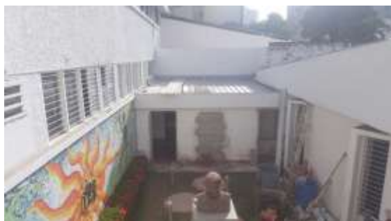
Instalacion Teja tipo Sandwich en la cubierta del deposito.
