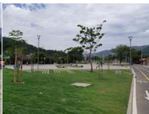
LUMINARIAS ENCENDIDAS PARA PRUEBA Y DISPONIBLES PARA USO DE LA COMUNIDAD-
