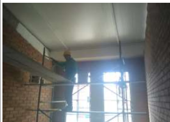
Pintura de vigas salones
