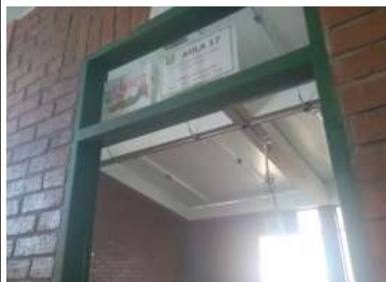
Instalación de red eléctrica salones
