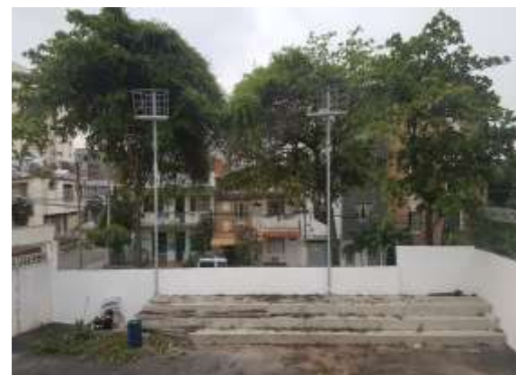
Instalación de Postes y canastas Patio 1- Patio 2
