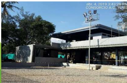
EDIFICIO DE SERVICIOS CANCHAS DE TENIS
