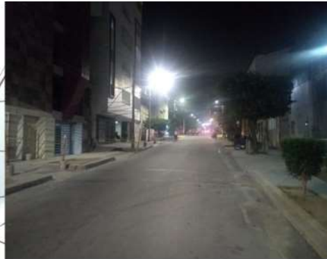
CALLE TOTALMENTE MODERNIZADA A TECNOLOGIA LED
