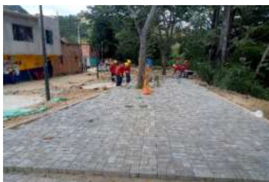
Instalación adoquín sendero y Mobiliario urbano.
