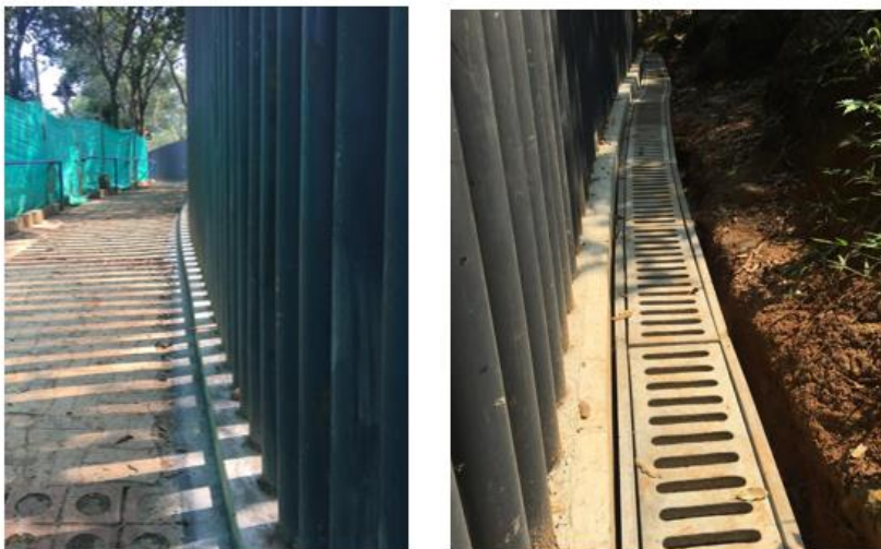
Suministro e Instalación de Cerramiento en tubería y Cárcamo prefabricado
