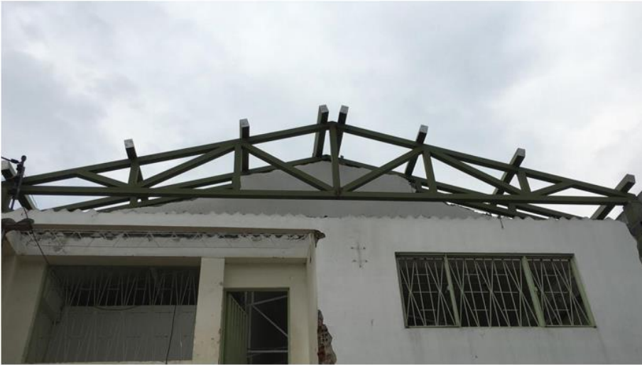
Ilustración 5. SUMINISTRO E INSTALACION DE ESTRUCTURA METALICA PARA TERMINADO DE CUBIERTA TIPO SANDWICH
