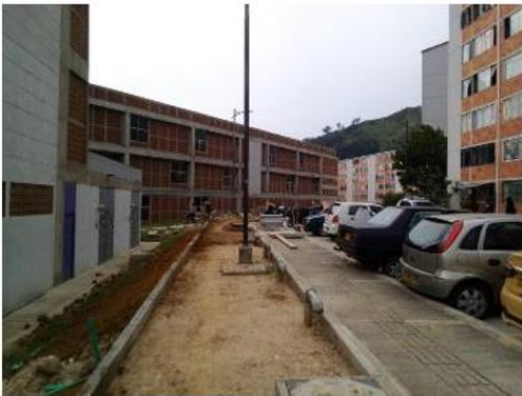
ACTIVIDAD DE REPLANTEO Y ESTRUCTURAS
