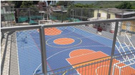
CANCHA MÚLTIPLE BARRIO LOS ÁNGELES
