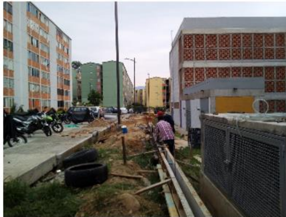
ACTIVIDAD DE REPLANTEO Y ARMADO DE ESTRUCTURAS
