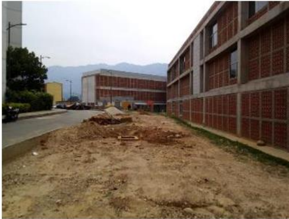
ACTIVIDAD DE REPLANTEO
