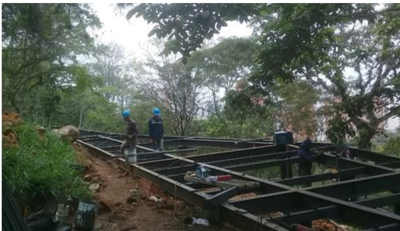
Montaje Estructura metálica en Tramo No 27 – Eje No 3
