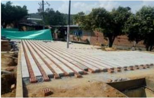
PISO EN DECK PLAZOLETA SECTOR 1
