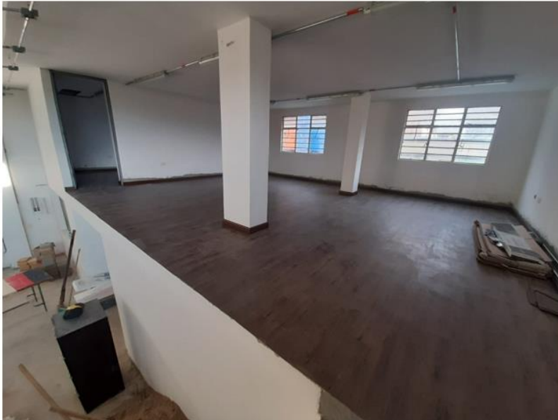
Ilustración 3. MUROS ACABADO EN ESTUCO Y PINTURA, SUMINISTRO E INSTALACION DE LUMINARIAS Y SUMINISTRO E INSTALACION DE PISO VINILO.
