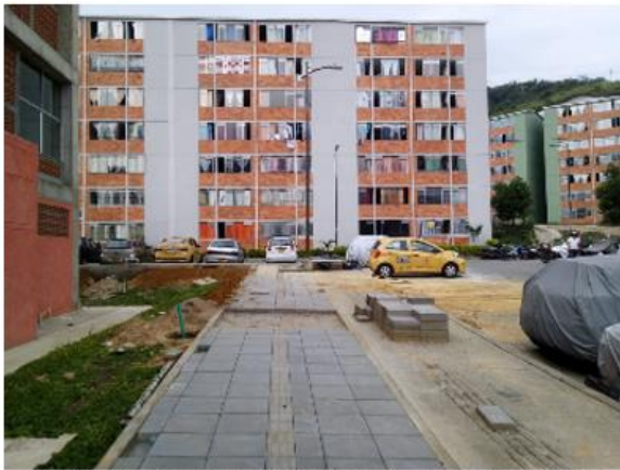
INSTALACION LOSETA PREFABRICADA ACCESO AL CDI
