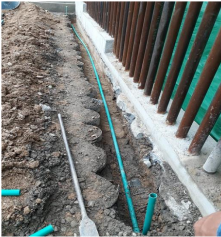
Canalización y alimentación eléctrica de luminarias en terraza corcovado
