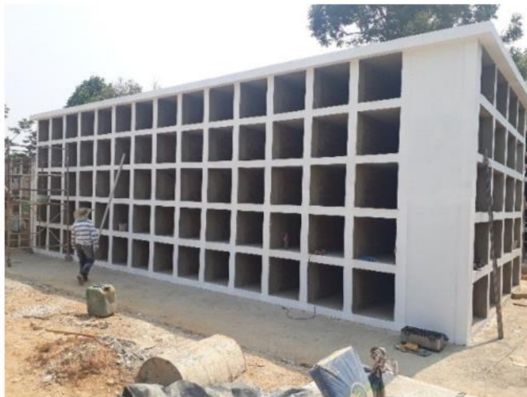
PINTURA MODULOS DE NUEVAS BOVEDAS
