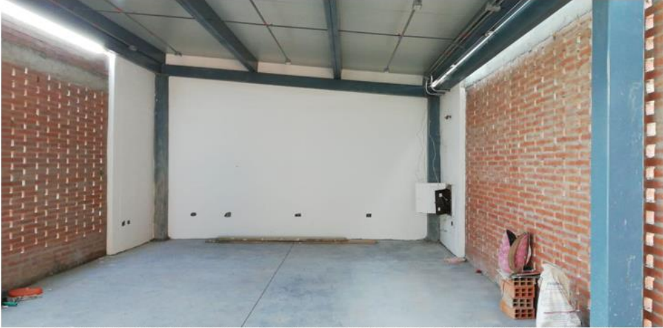
Ilustración 1. MUROS EN MAMPOSTERIA LADRILLO GRAN FORMATO DIMENSIONES DE 39X11X5 CM, PISO ACABADO CON HELICOPTERO, ESTRUCTURA METALICA, CUBIERTA TIPO SANDWICH, MURO ACABADO EN ESTUCO.
