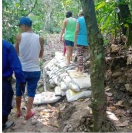
Vereda Granjitas –Pedregal Bajo
