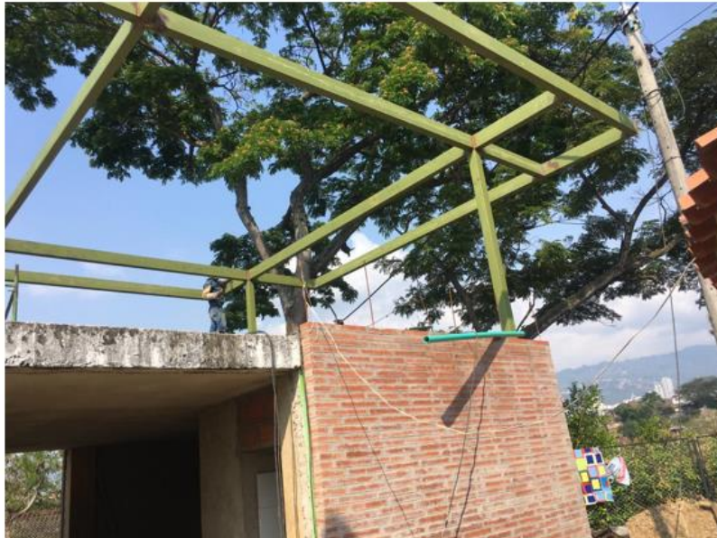
Ilustración 7. SUMINISTRO E INSTALACION DE FACHADA EN LADRILLO GRAN FORMATO; SUMINISTRO E INSTALACION DE ESTRUCTURA METALICA PARA INSTALACION DE PERGOLAS EN WPC.
