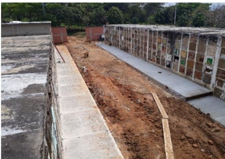
CONFORMACION DE ANDENES
