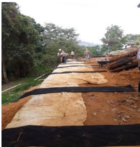
Ejecución de ultimas 2 capas tratamiento en plazoleta k 0+220
