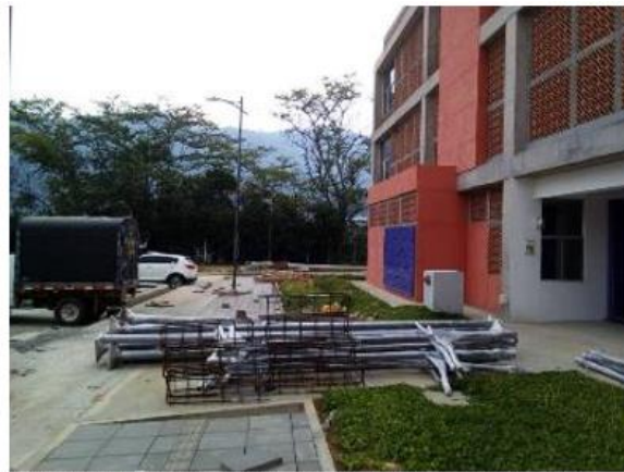
INSTALACION LOSETA PREFABRICADA ACCESO AL CDI
