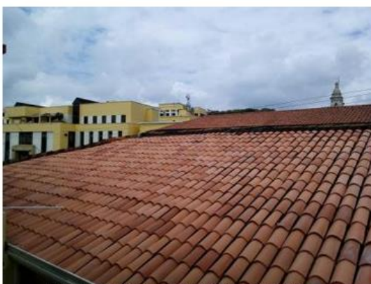
REMODELACION EXTERIOR CUBIERTA
