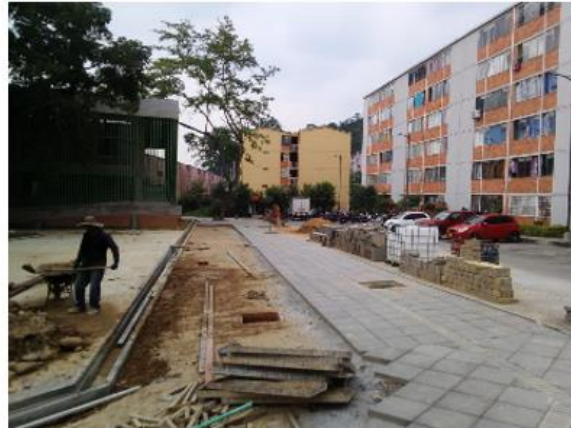
INSTALACIÓN LOSETA PREFABRICADA ACCESO PRINCIPAL
