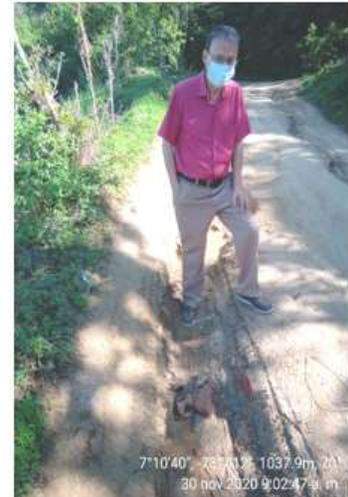
En el sector de la vía de la vereda el Angelinos – Santa Rita se observa la banca de la vía con cárcavas generadas por las escorrentías superficiales de aguas lluvias haciéndola.
