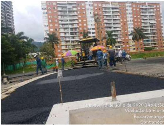
APLICACIÓN PAVIMENTO EN ASFALTO PISTA
