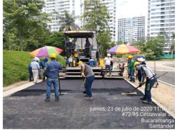
EXTENDIDA Y COMPACTADA MATERIAL ASFALTICO PISTA
