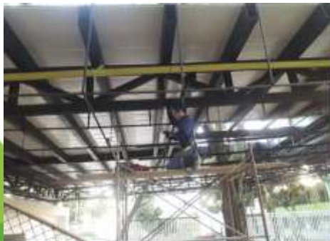
ESTRUCTURA METÁLICA Y CUBIERTA COMEDOR
