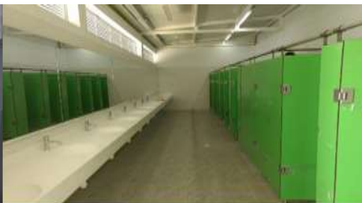
CONSTRUCCIÓN DE LAS BATERÍAS DE BAÑOS (INTERNO)
