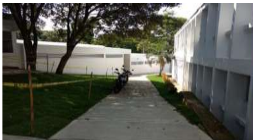
CONSTRUCCION BATERIAS DE BAÑOS (EXTERNO)
