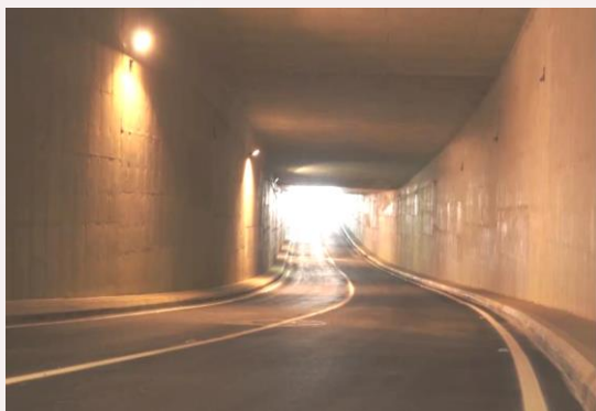
Deprimido eje 3 Avenida Quebrada seca al occidente
