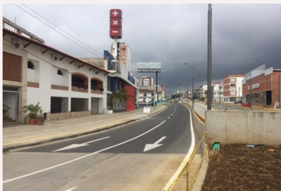
Tramo 2 – eje 8 carreras 27 Sentido norte sur
