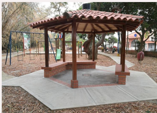
Demolición y construcción de tres Kiosco Barrió Candiles
