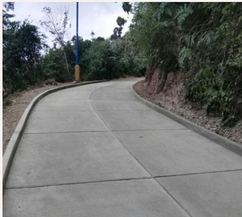
Mejoramiento Tramo de via Vereda Retiro Grande
