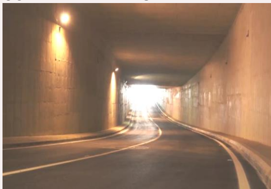
Deprimido eje 3 Avenida Quebrada seca al occidente
