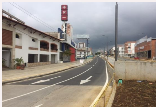
Tramo 2 – eje 8 carreras 27 Sentido norte sur
