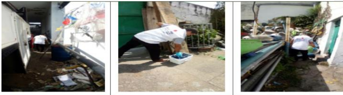
Gráfica No. 20. Intervención de la Bodega de almacenamiento de materiales del alumbrado público de la Puerta del Sol.
