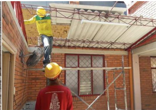
DESMONTE DE CUBIERTAS BAÑOS -COLEGIO ANDRÉS PÁEZ SOTO JOYA
