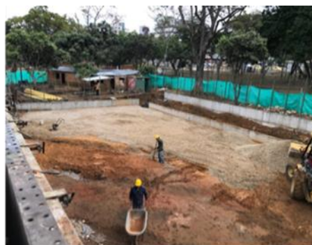
ESTRUCTURA DE PISO CON FILTROS CANCHA ORIENTAL
