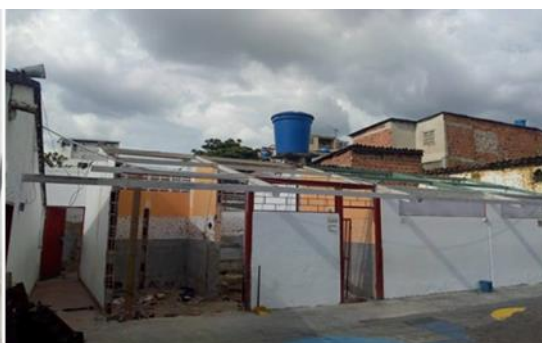
DESMONTE DE CUBIERTA COLEGIO SANTA MARÍA GORETTI SEDE “B”
