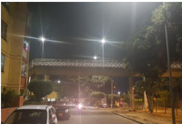
CIUDAD BOLIVAR – ILUMINACION PUENTE CIUDAD BOLIVAR – AUMENTO LA SEGURIDAD E INCENTIVA EL PUENTE PARA CRUZAR TAN CONGESTIONADA AVENIDA
