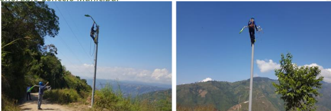
Montaje de luminarias tipo led con brazo metálico en sector rural del municipio de Bucaramanga
