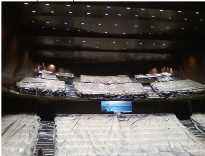
Terminación instalación silletería de la Gran Sala
