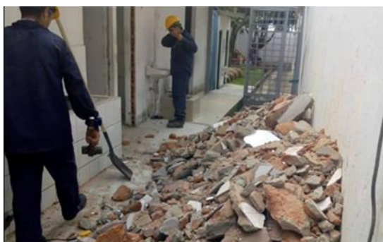
DEMOLICIÓN MUROS DE MAMPOSTERÍA Y MESONES COLEGIO AURELIO MARTÍNEZ MUTIS SEDE “B”
