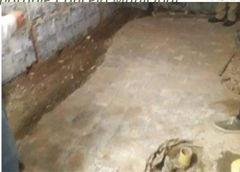
DEMOLICIÓN DE PISO Y MUROS - COLEGIO LA JUVENTUD
