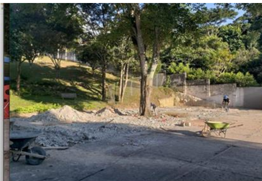
DEMOLICIÓN COCINA Y COMEDOR EXISTENTE
