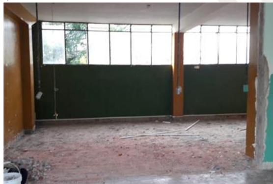
DEMOLICIÓN DE PISOS Y ENCHAPES -COLEGIO SANTANDER
