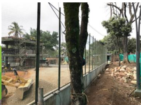
CERRAMIENTO ORIENTAL-ESTRUCTURA EDIFICIO
