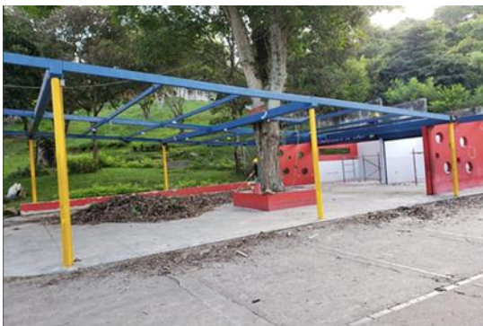
DESMONTE DE CUBIERTA EXISTENTE
