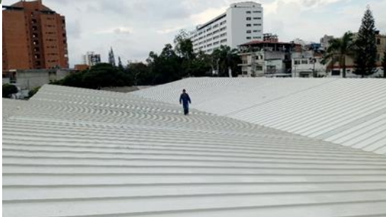
CUBIERTA COSTADO NORTE DE LA PLAZA GUARÍN, EXTERNA
