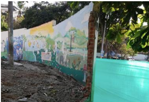
DEMOLICIÓN MURO DE CERRAMIENTO - COLEGIO MAIPORE
