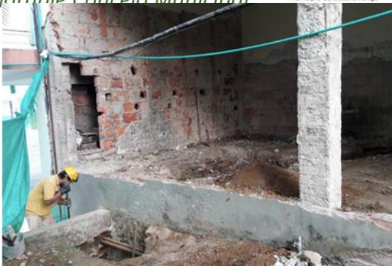
DEMOLICIÓN DE MUROS DE MAMPOSTERÍA - COLEGIO SANTANDER
