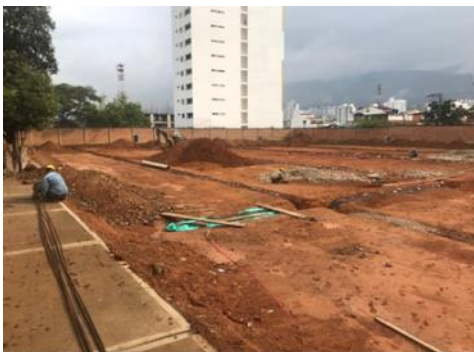
ACONDICIONAMIENTO DEL TERRENO – CONSTRUCCION DE FILTROS
