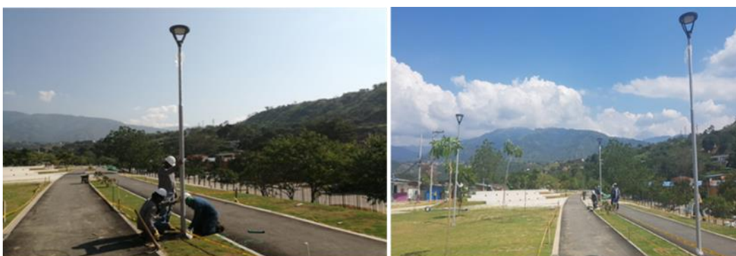
Parque lineal rio de oro – Montaje de luminarias en ciclo ruta para iluminar alegría
