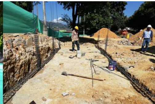
CONSTRUCCIÓN DE LAS BATERÍAS DE BAÑOS - COLEGIO MAIPORE
