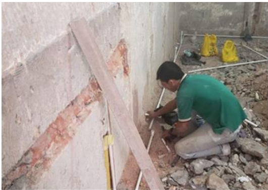
DEMOLICIÓN ENCHAPES E INSTALACIONES SANITARIAS - COLEGIO POLITÉCNICO SEDE “B”
