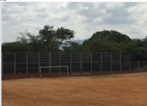
Cerramiento Sur Cancha de Futbol
