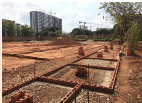
INICIO CONSTRUCCION DE GRADERIAS
