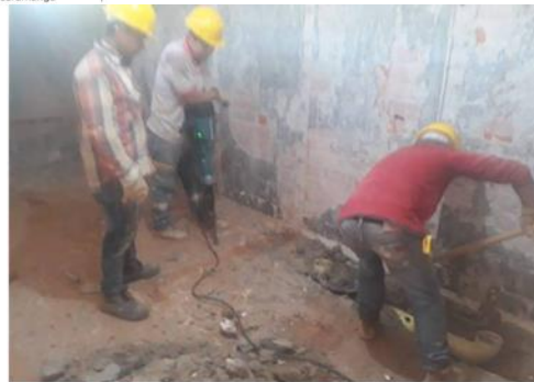
DEMOLICIÓN ENCHAPES - COLEGIO LA JUVENTUD
