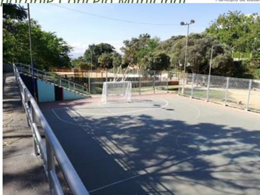
CANCHA MULTIPLE HACIENDA SAN JUAN
