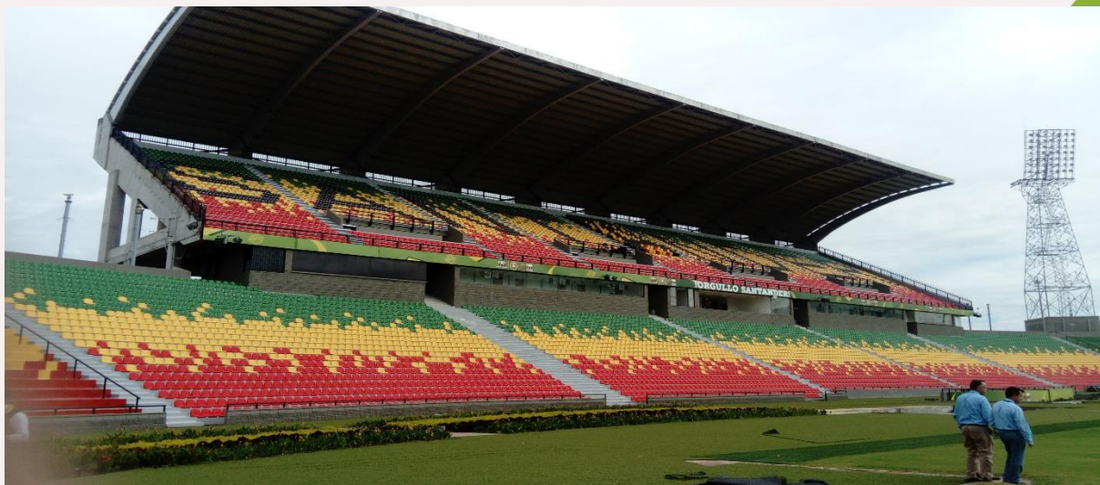
Figura 20 Revisión técnica Gradería Fuente: Gestión del riesgo
