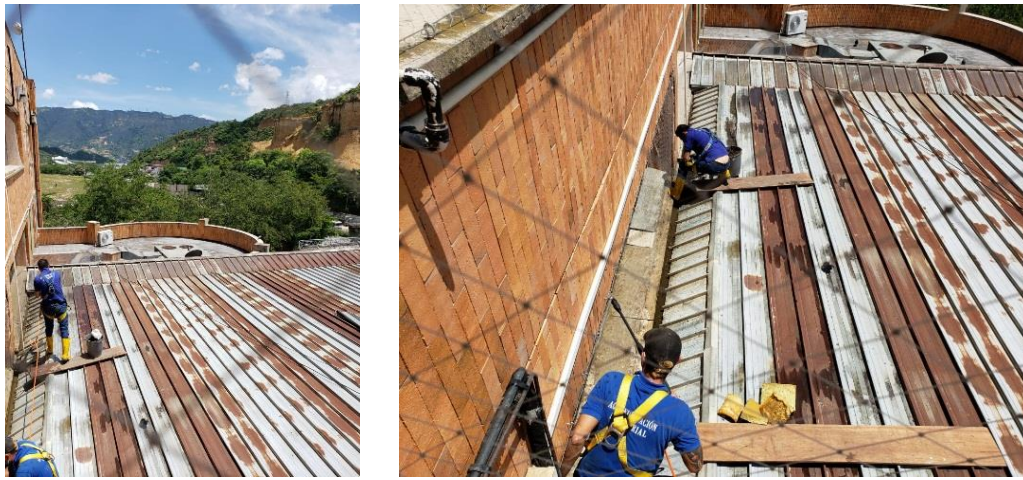
Fotografía 3 Lavado de techo 5 piso sede administrativa
