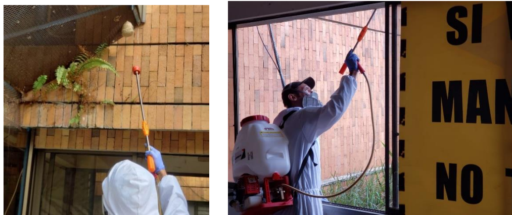
Fotografía 4 Eliminación de Panales
