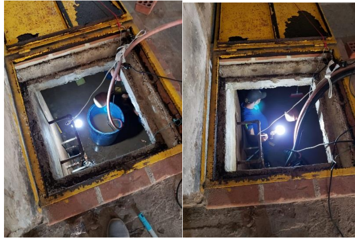
Fotografía 5 Lavado y desinfección de tanques DTB
